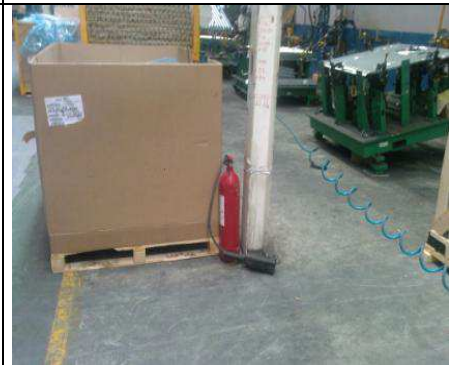
Extincteur non fonctionnel par terre
