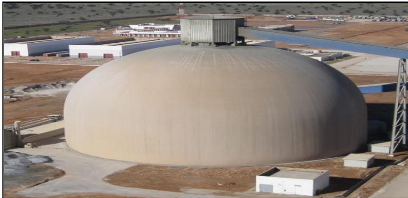
Figure 7:Dôme de stockage de clinker
