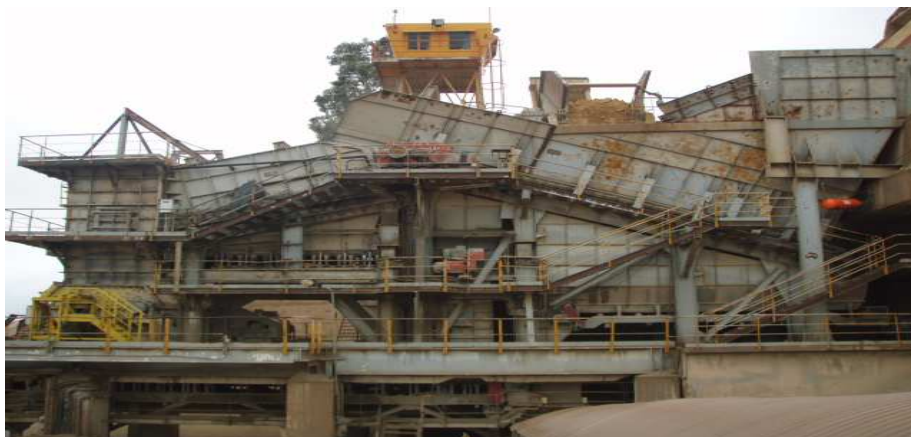
Figure 2: Vue globale du concasseur HAZEMAG
