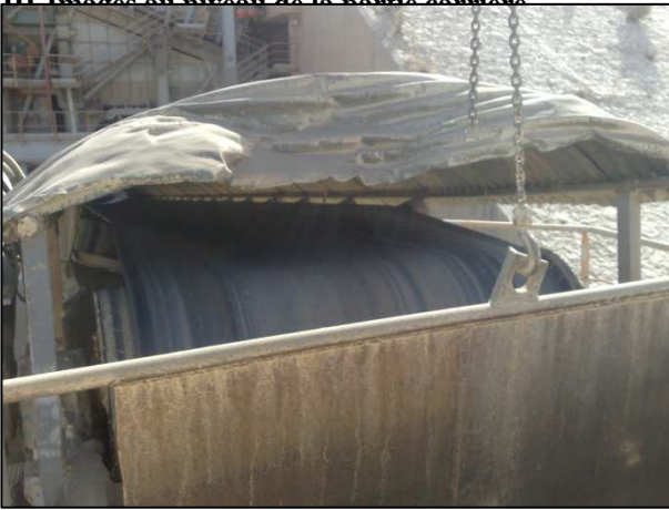
Figure 1 : Convoyeur sortie concasseur. Carrière HAZEMAG
