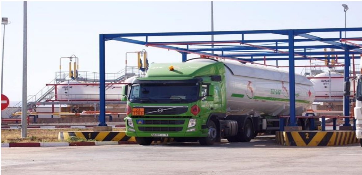
Figure 6 :Poste de déchargement de GPL
