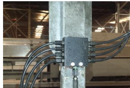
Distributeur SSV8 des paliers du convoyeur entrée caisses
