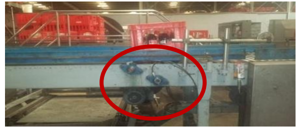
Paliers du convoyeur entrée caisses
