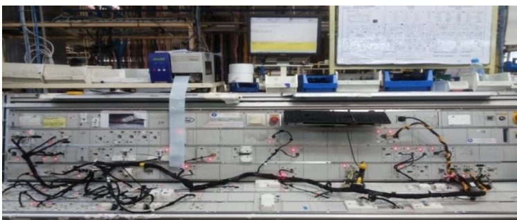
Figure 33 : Banc du test électrique.
