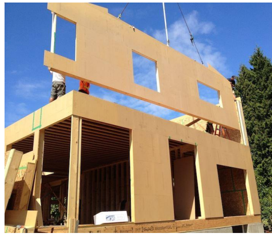
Figure 42 : Construction en panneaux massifs [Mai14].
