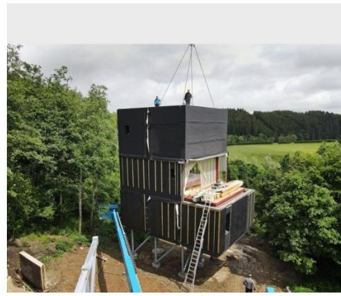
Figure 49 : Chantier_ Hosomi_Dethier Architecture_2011 [DN11].
