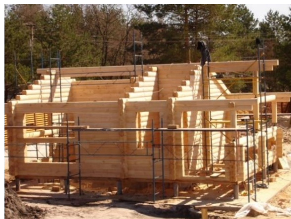
Figure 41 : Construction en bois massif empilé [BW15].
