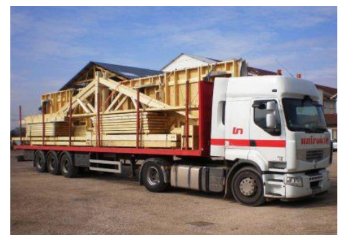
Figure 29 : Transport d'éléments préfabriqué [Esp19].
