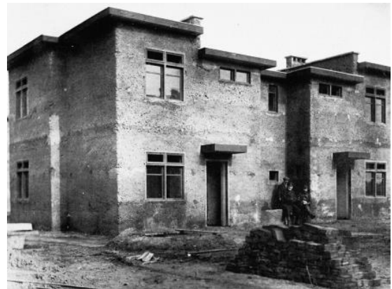
Figure 4: Façade_ Cité industrielle Petite Russie [Coh19].
