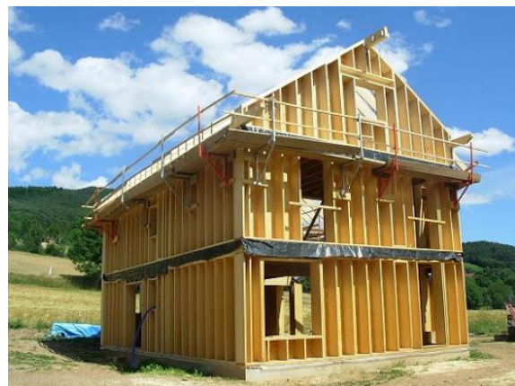
Figure 39 : Construction en ossature bois [Egb17].
