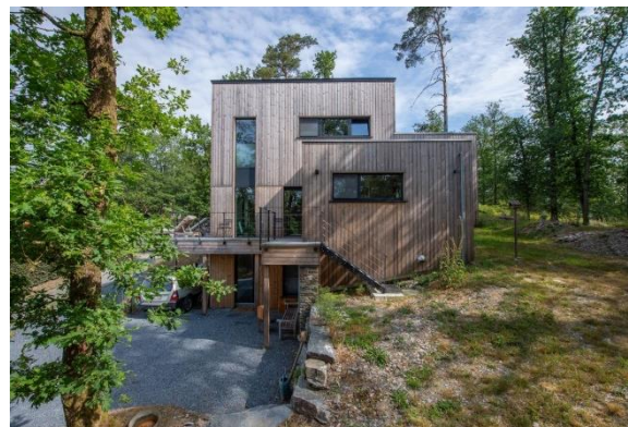
Figure 104 : Maison unifamiliale_Namur [Nat21].
