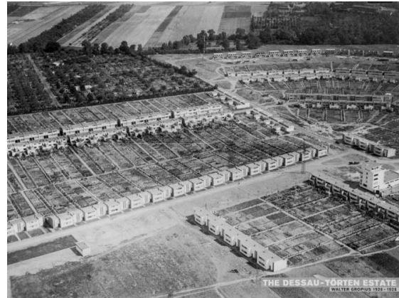
Figure 77 : Vue aérienne_Cité Törten [Wik21].
