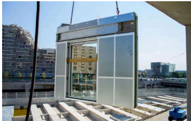
Figure 31 : Panneaux de bardage [Sch20].
