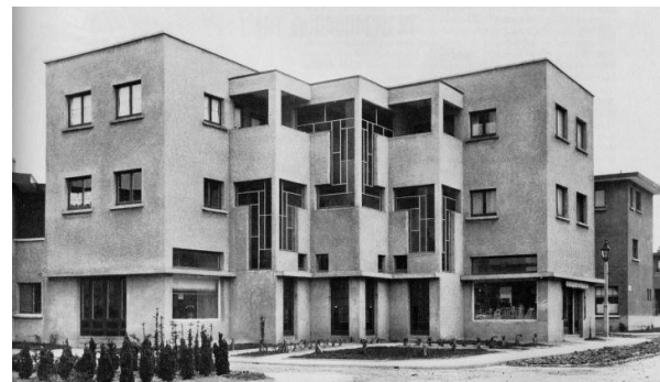
Figure 8 : Façade_ La Cité Moderne [Coh19].
