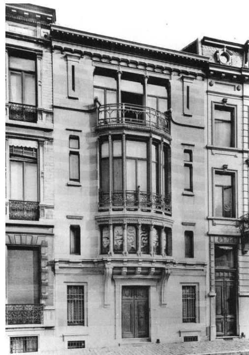
Figure 55 : Façade_ Hôtel Tassel [Coh19].
