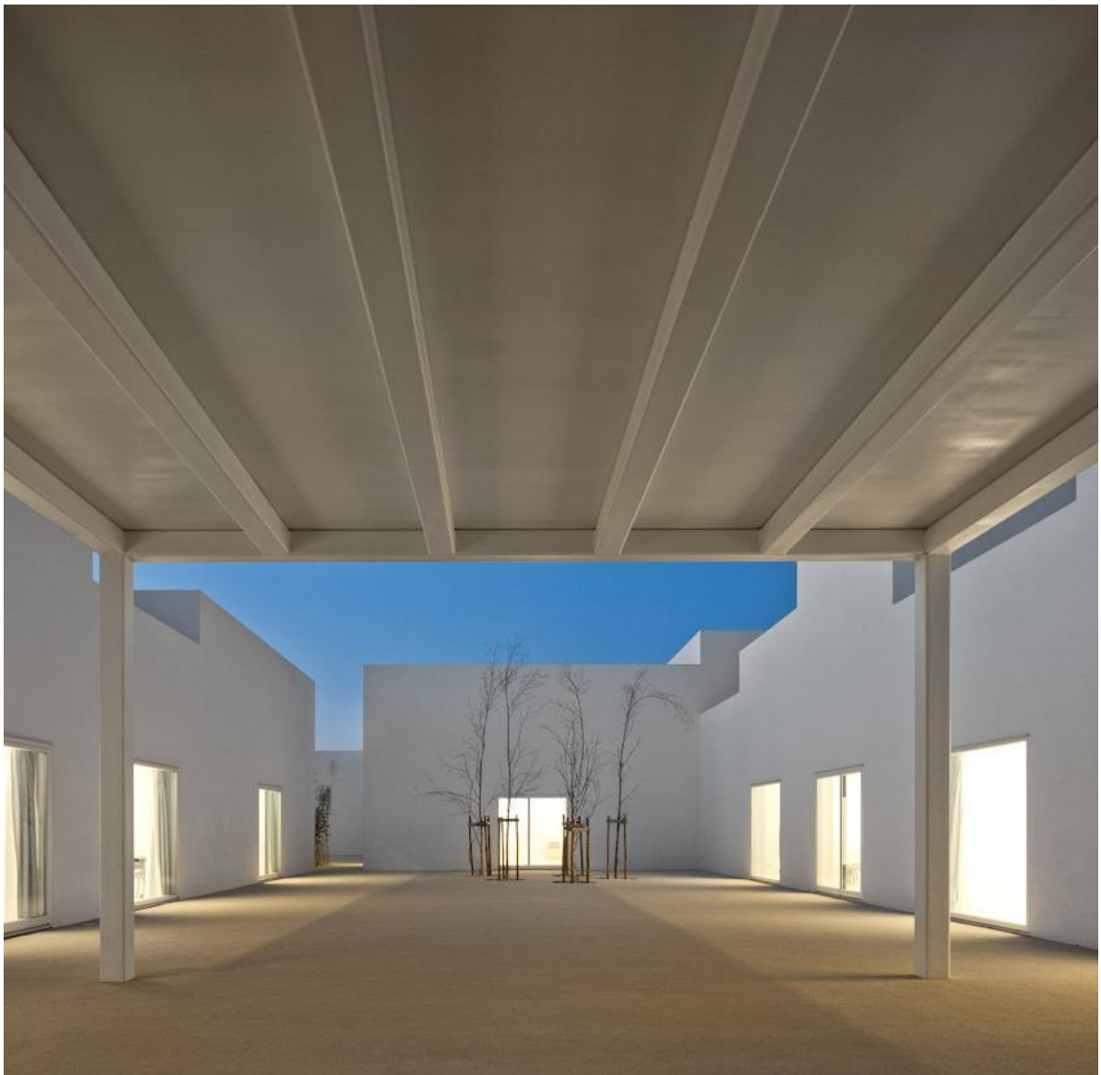
Figure 119 Photo cour intérieure
