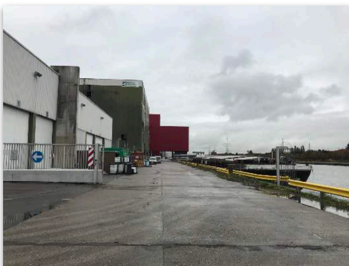
Photo du quai près de l'usine de bio-méthanisation à Herstal, exprime la relation portuaire.
