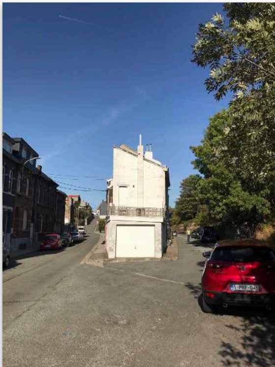
12. Photo d'un îlot résiduel sans avant ni arrière à Herstal.
