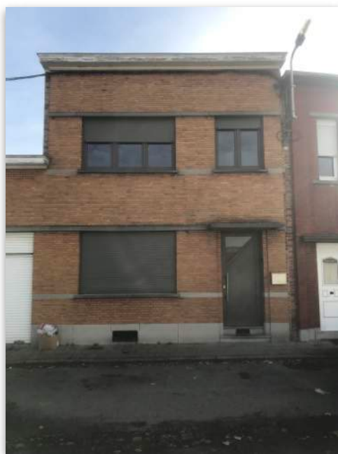
Exemple de façade d'un habitat ouvrier à Herstal.
