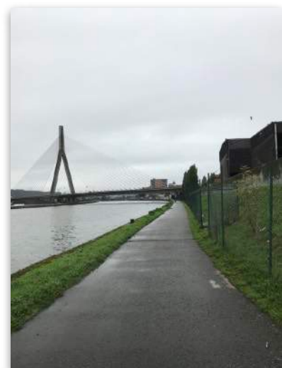
Photo du piétonnier le long du canal Albert à Herstal, exprime une relation différente à l'eau que le port par une balade le long de du Canal Albert.
