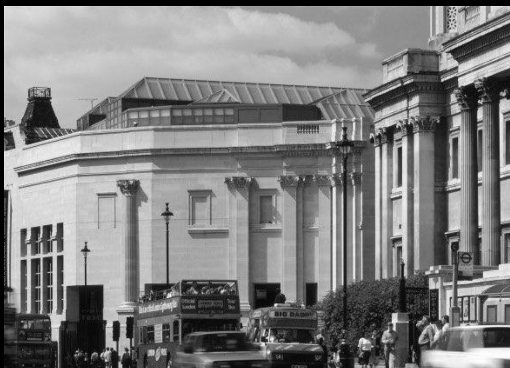
fig. 12 : A gauche, l'extension de 1991 de la National Gallery, la Sainsbury Wing de Robert Venturi. A droite, le bâtiment existant.
