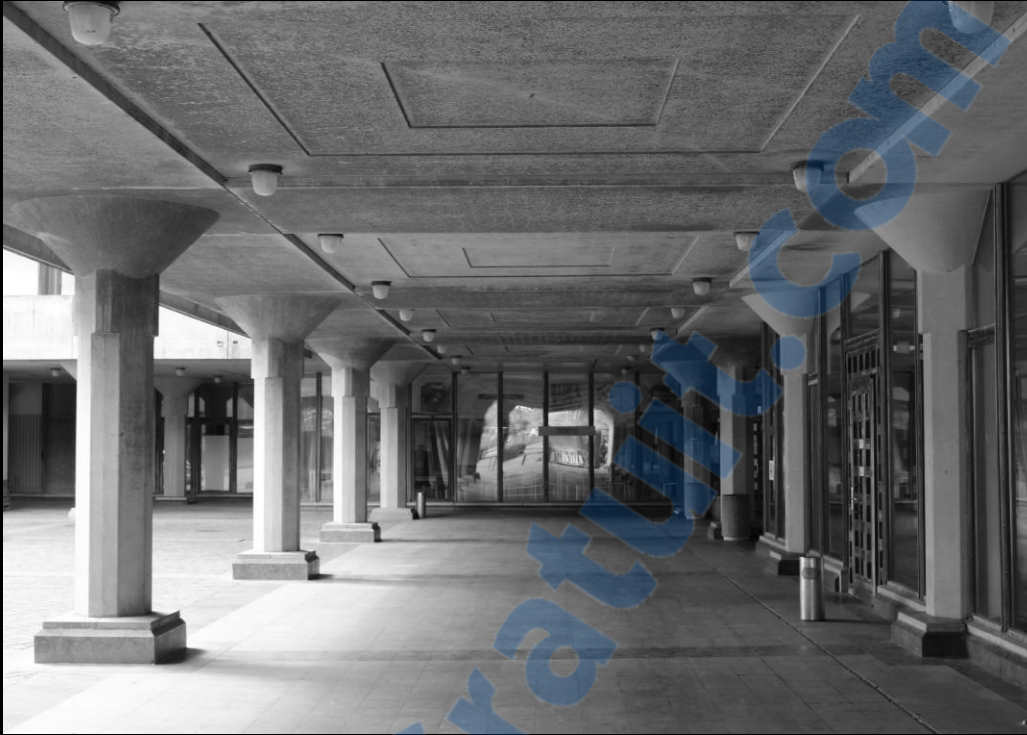
fig. 50 : Préau extérieur avec colonnes servant de système constructif principal, apparentes.
