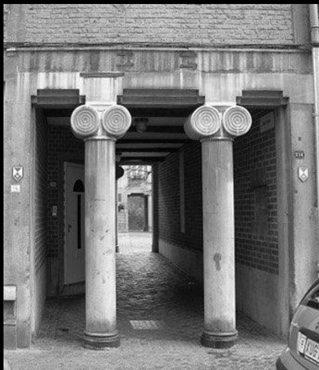
fig. 39 : Porche d'entrée de la Cour Saint-Antoine , depuis la rue Hors-Château.
