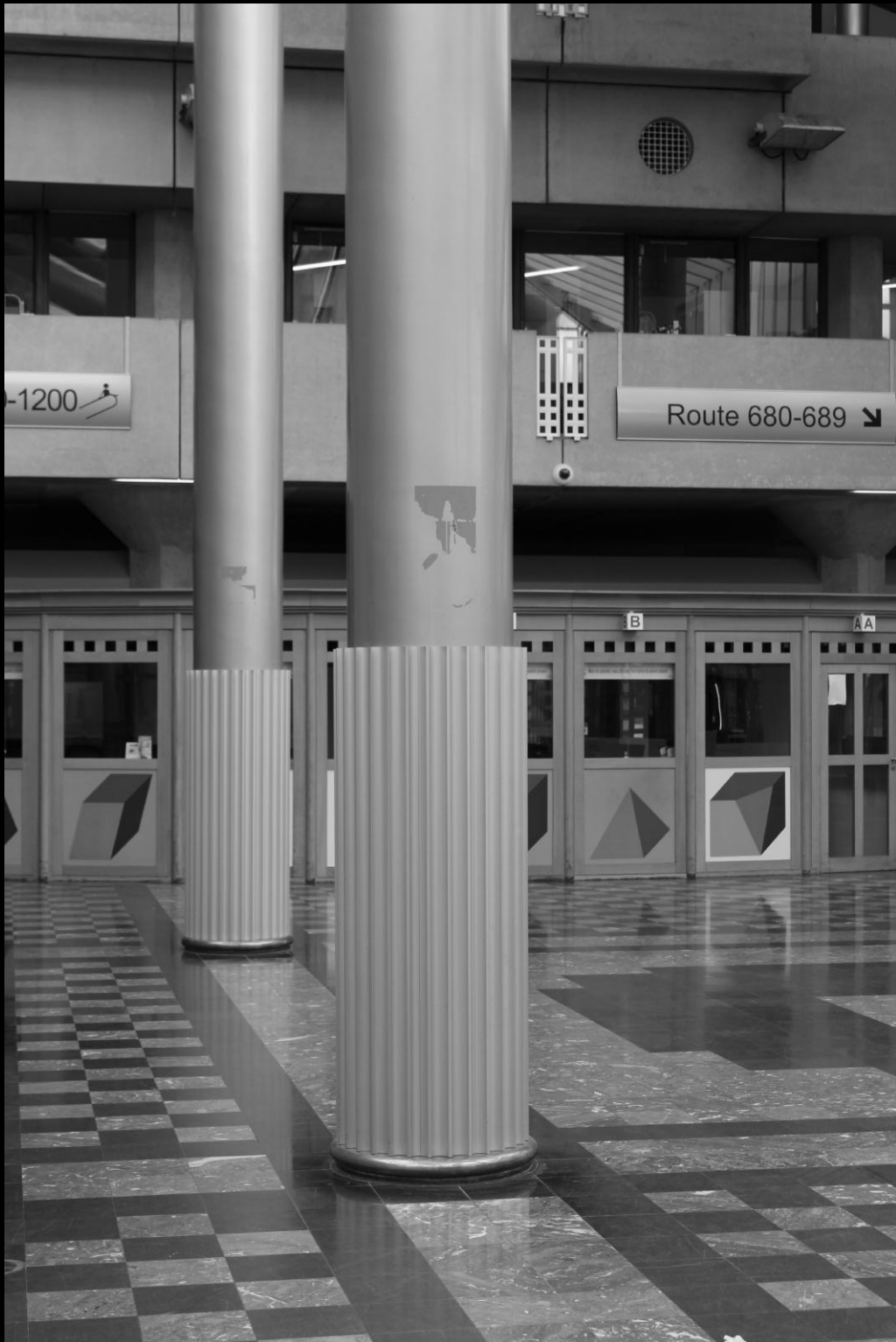
fig. 56 : Colonne type supportant la grande verrière.
