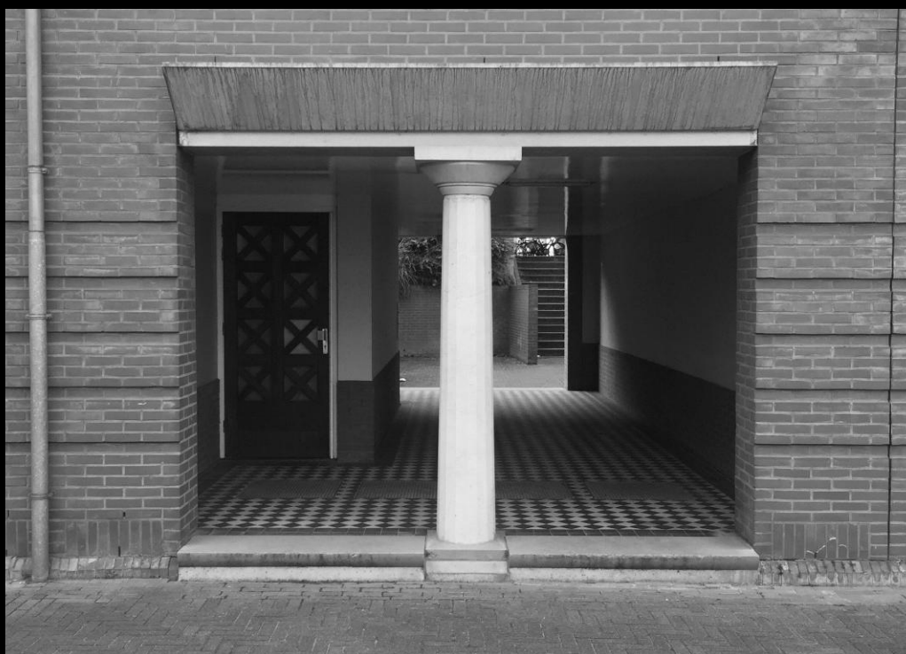
fig. 40 : Porche d'entrée de l'ensemble Hoogfrankrijk , depuis la cour intérieure.
