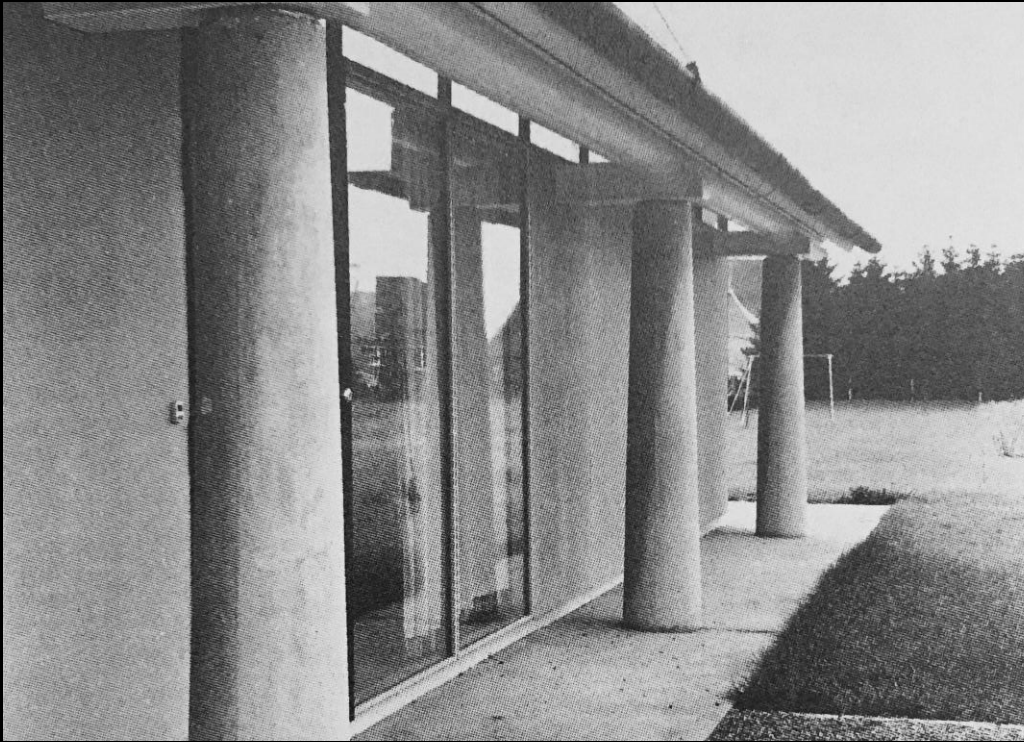
fig. 31 : Extérieur de la Maison Schoonbroodt de 1974.
