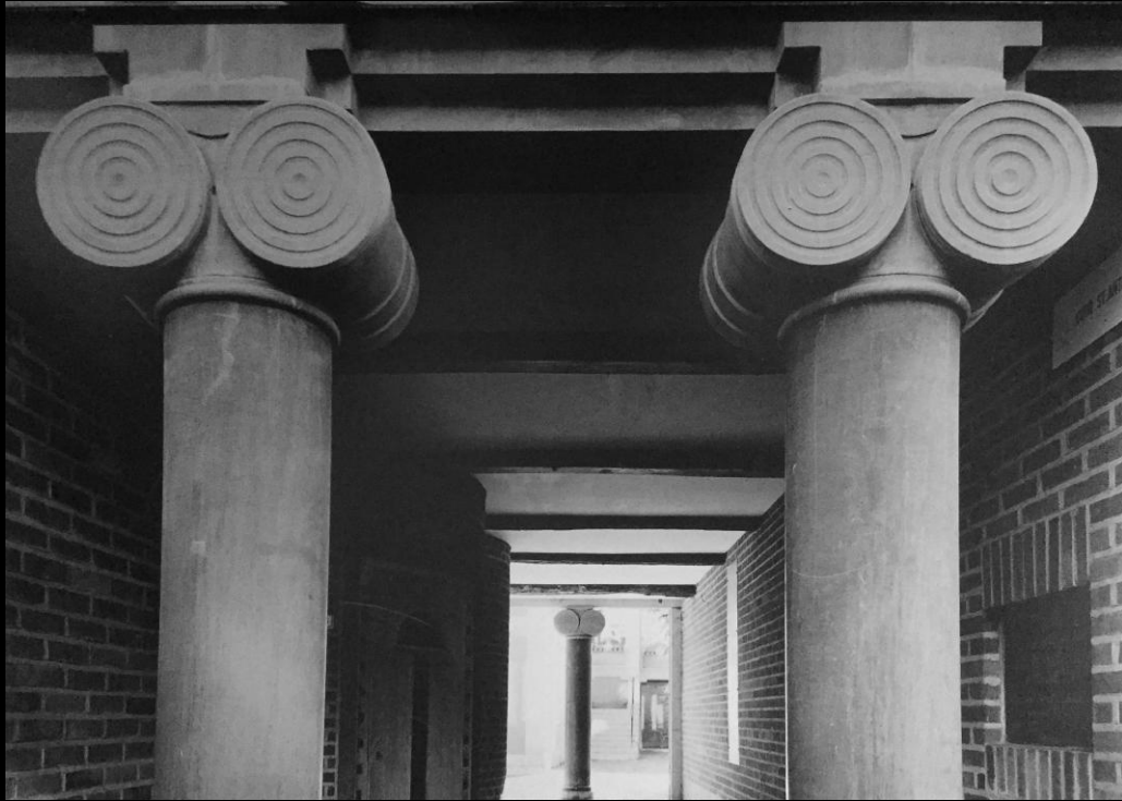
fig. 34 : Colonnes du porche d'entrée de la Cour Saint-Antoine depuis la rue Hors-Château.
