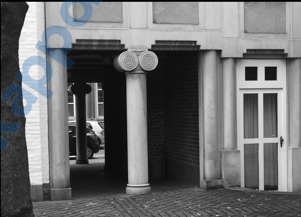
fig. 6 : Porche d'entrée de l'ensemble de logements de la Cour Saint-Antoine .
