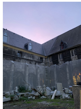
Fig. 55 - Stockage des matériaux dans la cour du cloître de la cathédrale, 2019 de robots-tailleurs, 2019
