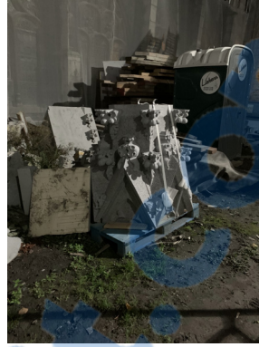
Fig. 50 - Ancienne / Nouvelle base d'un pinacle, 2019
