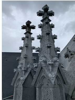
Fig. 53 - Nouveaux pinacles de la cathédrale reproduits à l'aide de robots-tailleurs, 2019
