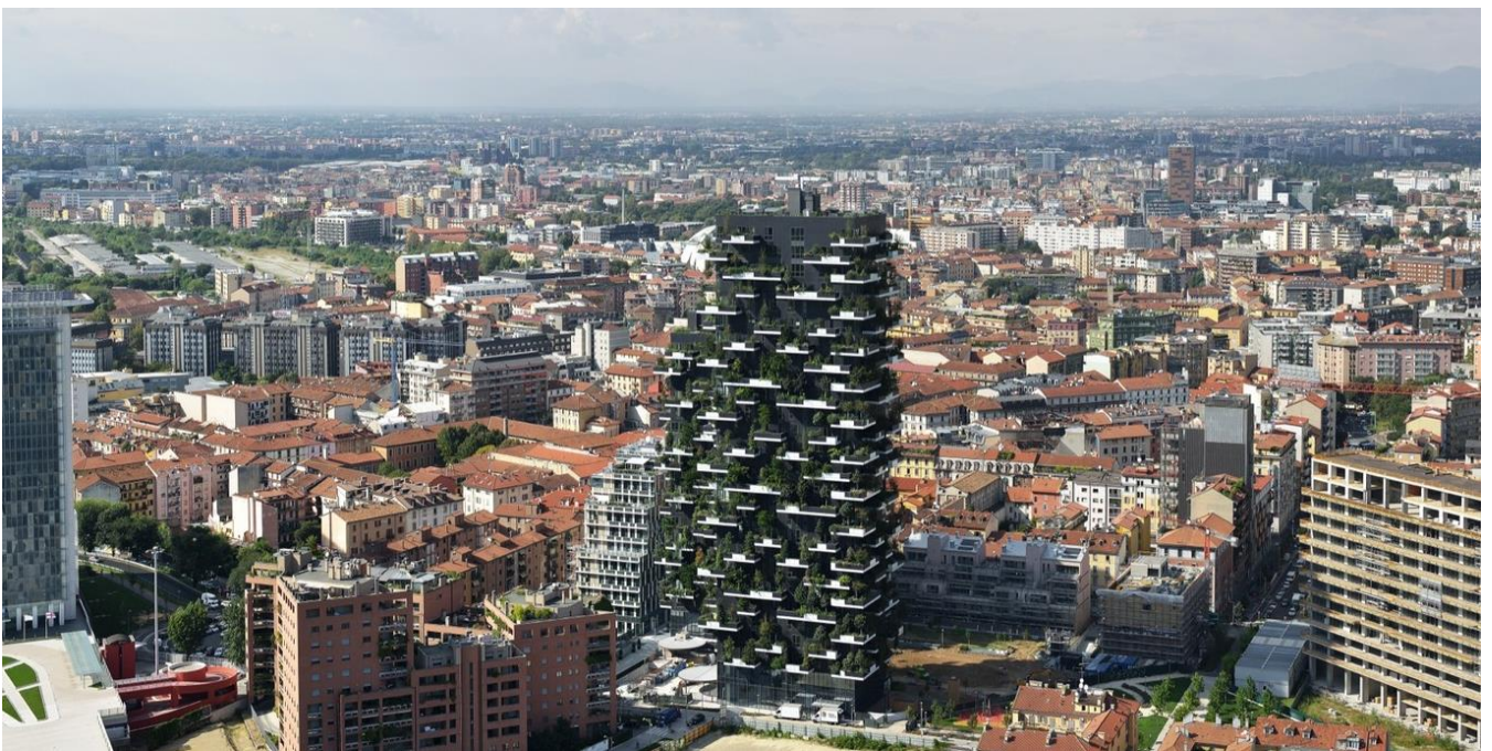
Figure 1: Photographie du Bosco Verticale.
