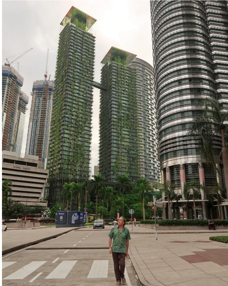
Figure 28: Mur végétal réalisé par Patrick Blanc en Malaisie.
