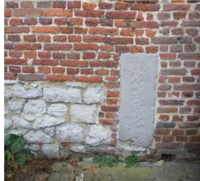
L'élévation côté rue est semblable à celle côté cour. Elle est actuellement en mauvais état suite à l'accolement d'un hangar industriel pendant cinquante années.
