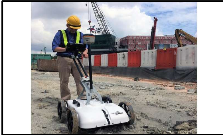
Figure II.16: Radar à pénétration de sol (GPR) [42].
