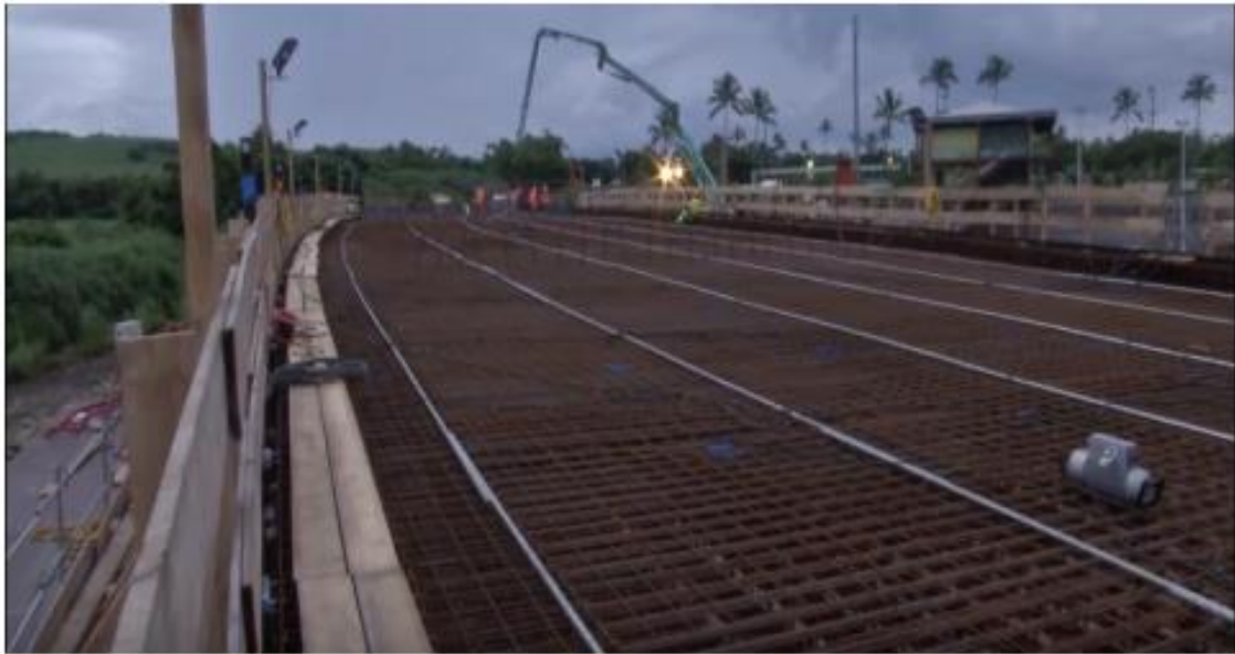
Figure 26:mise en place de ferrailages d'hourdis
