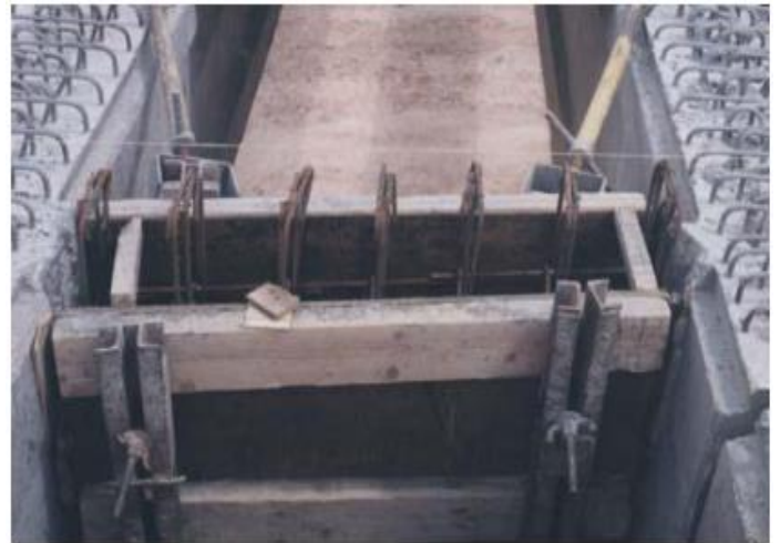
Figure 25: coffrages des entretoises
