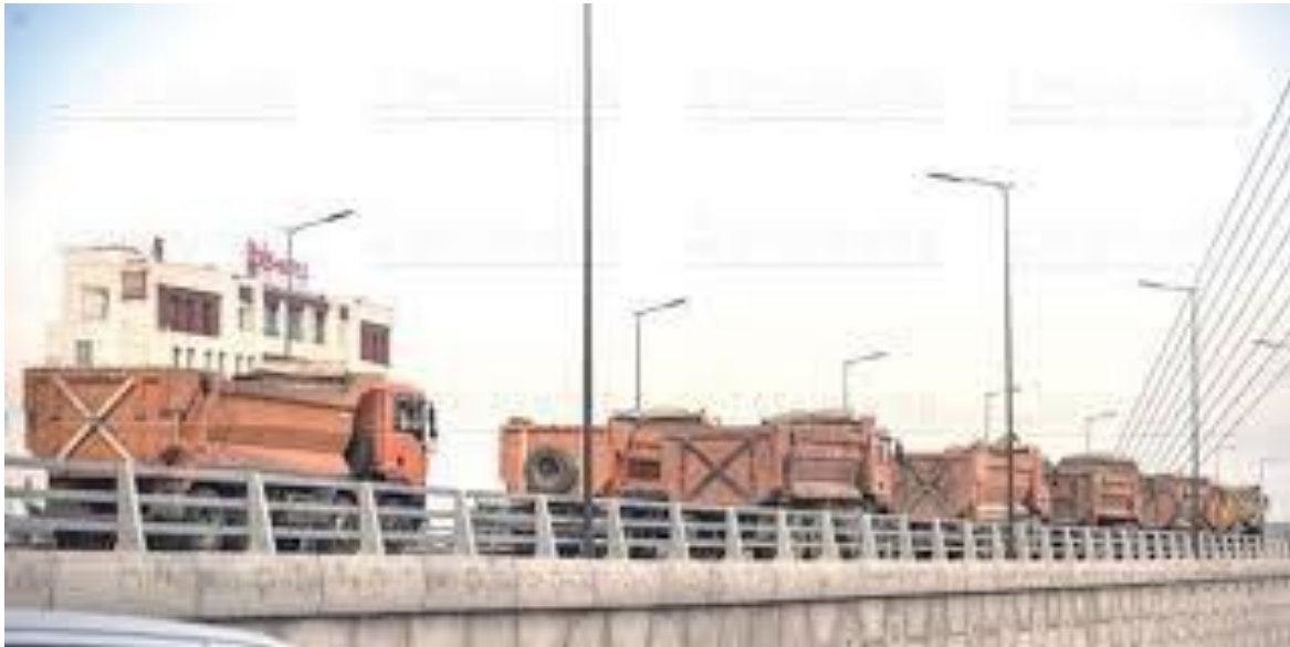
Figure 30:essai de chargement avec camion lourds
