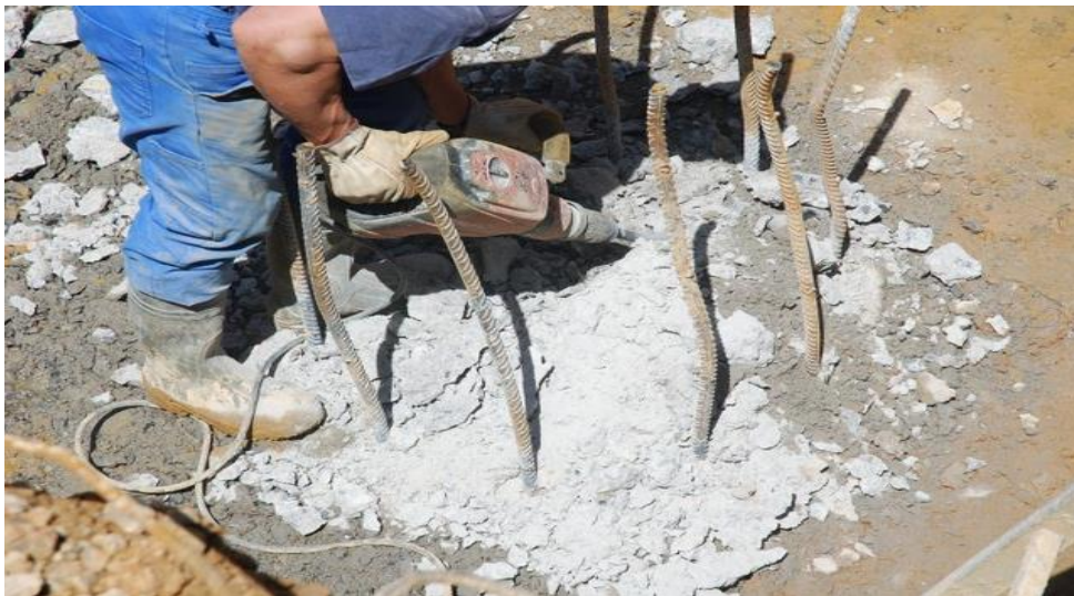
Figure 18: réalisation de semelle
