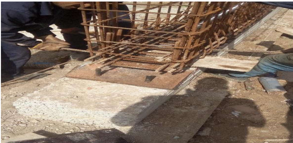
Photo 4.11 : Pose des socles d'appuis
