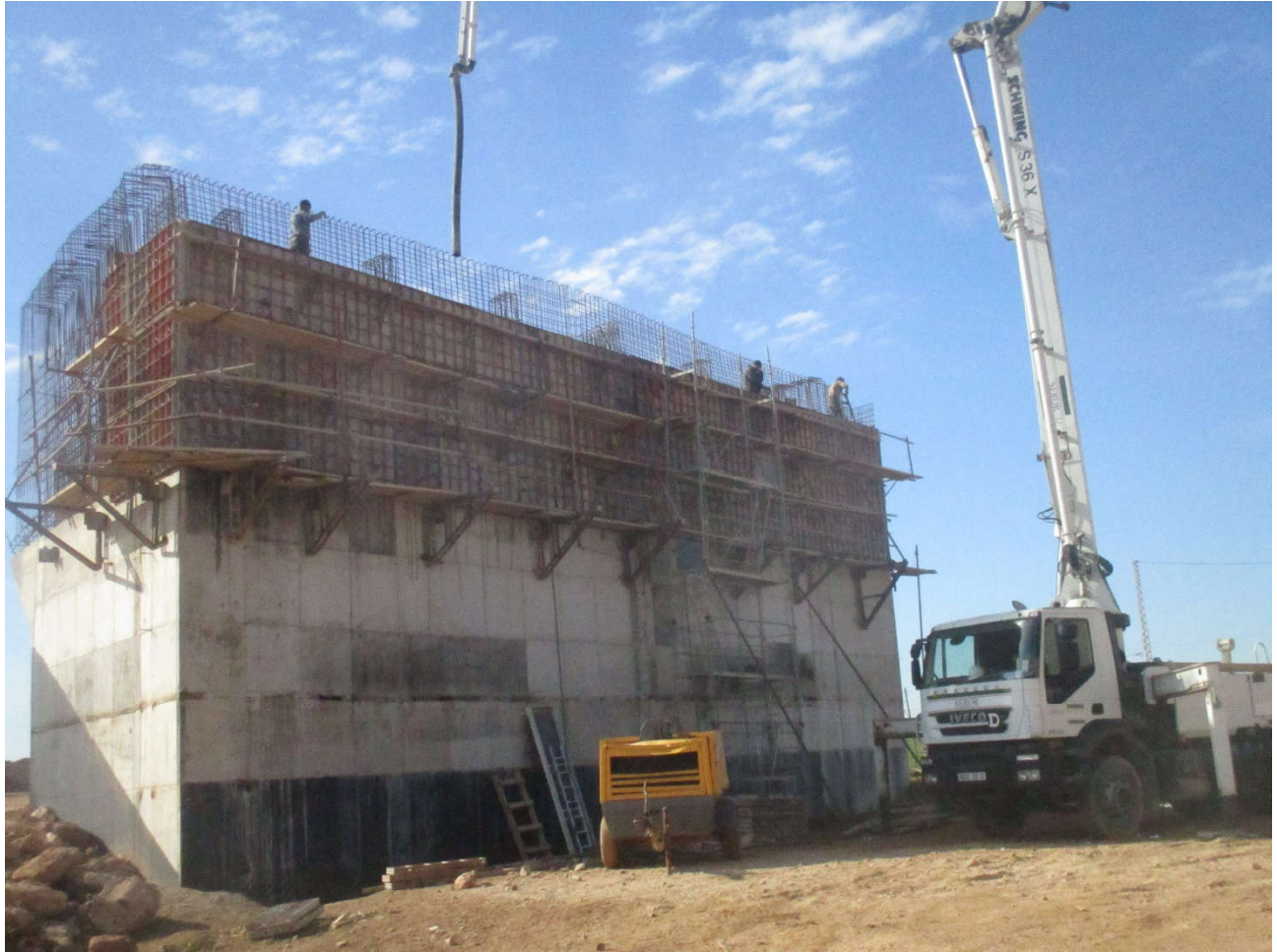
Photo 4.6 : mise en place du coffrage de la culée
