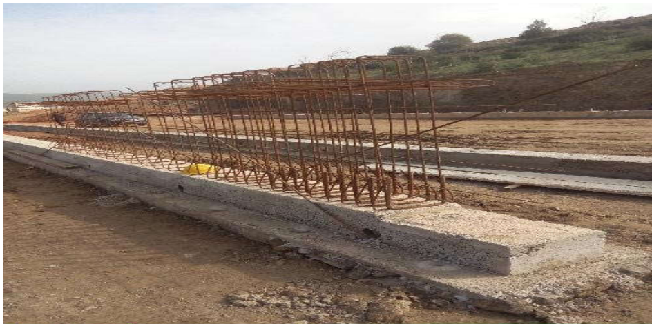
Photo 4.9 : Réalisation du socle de poutre
