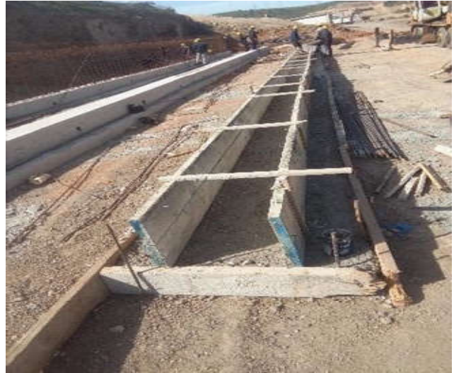
Photo 4.9 : Réalisation du socle de poutre
