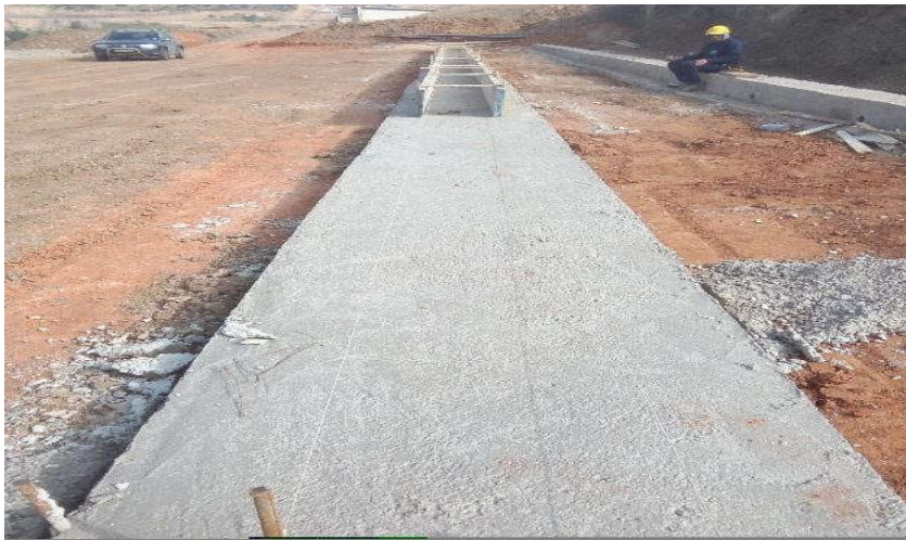
Photo 4.8 : Pose du béton de propreté
