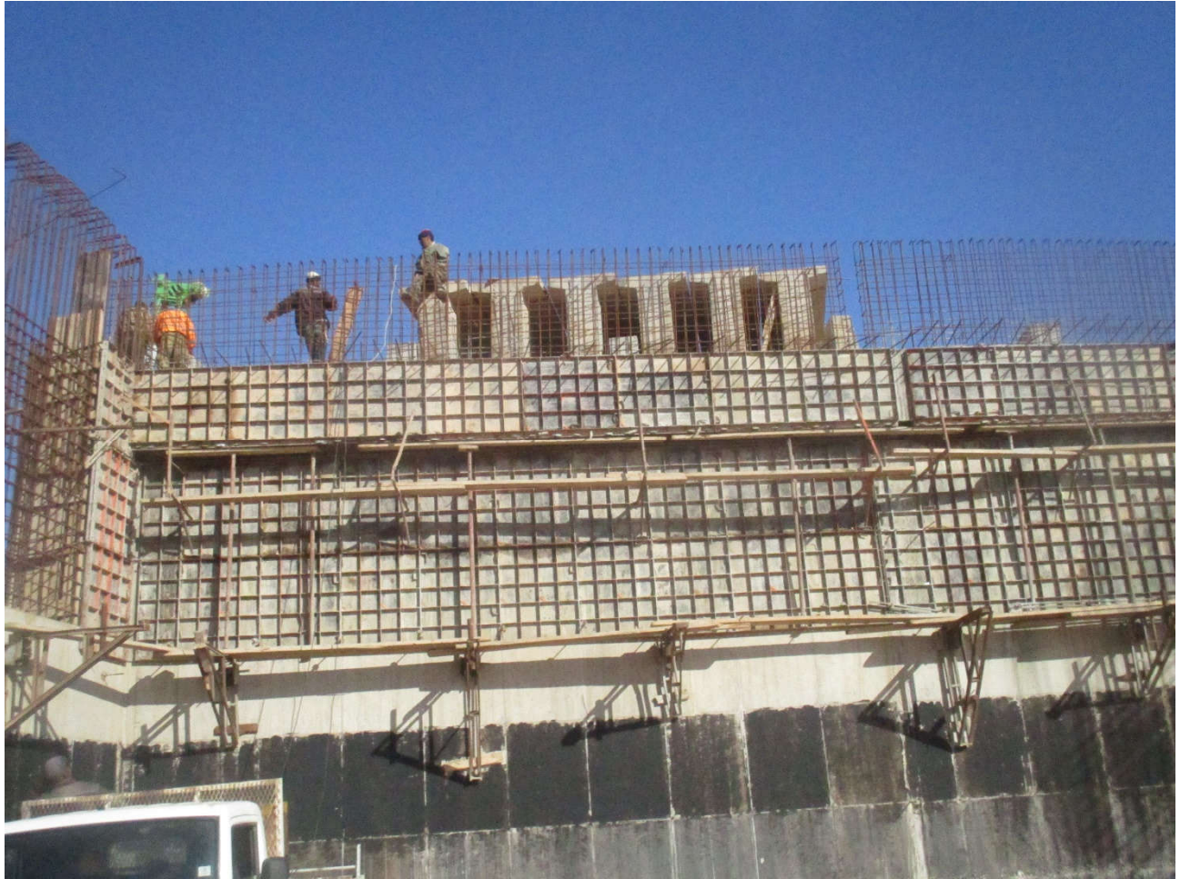
Photo 4.7 : mise en place du coffrage de la culée
