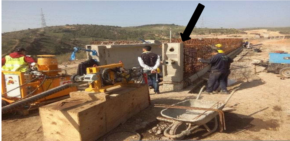
Photo 4.12 : Pose des abouts de poutre et passage des gaines
