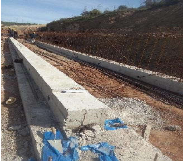
Photo 4.9 : Réalisation du socle de poutre
