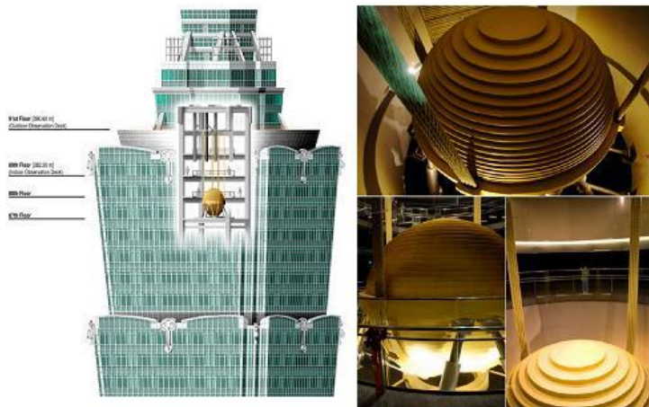
Figure 2.2: TMD pendulaire de la tour de Taipei101 [32]
