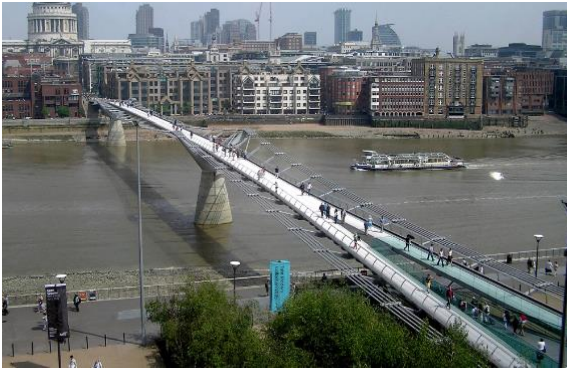
Figure 2.6 : Le Millennium Bridge Londres
