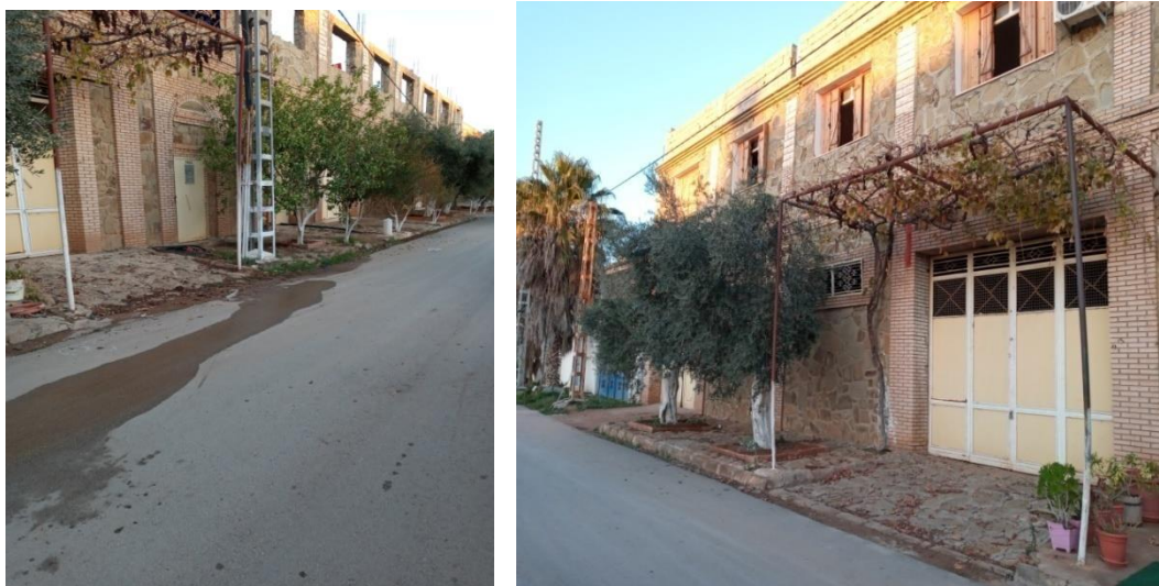
Figure II.4 : Vue de façade de la Maison
