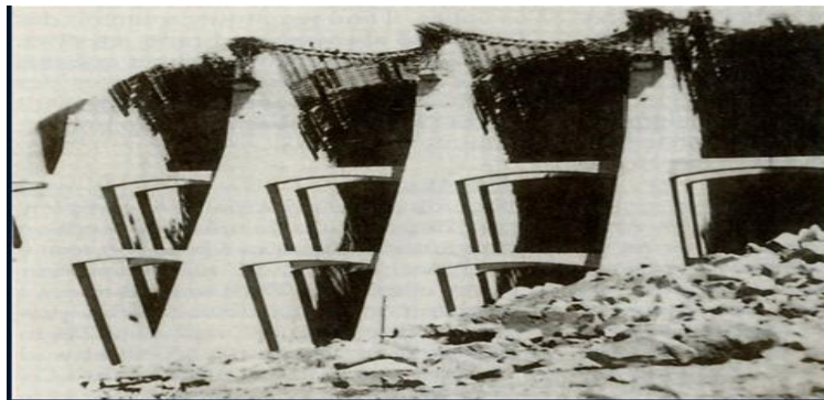
Photo III.3 : Travaux de surélévation du barrage de Beni Bahdel [3]
