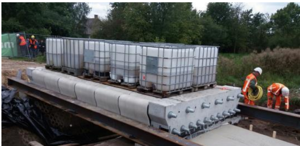
Figure 3.9: Passerelle réalisée en voussoirs imprimés et assemblés par la technique de la précontrainte. Visualisation des blocs d'ancrage [7]
