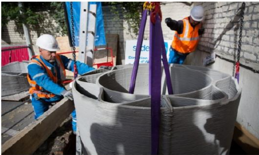
Figure 2.3: Fosse d'inspection souterraine (XtreeE, 2017).
