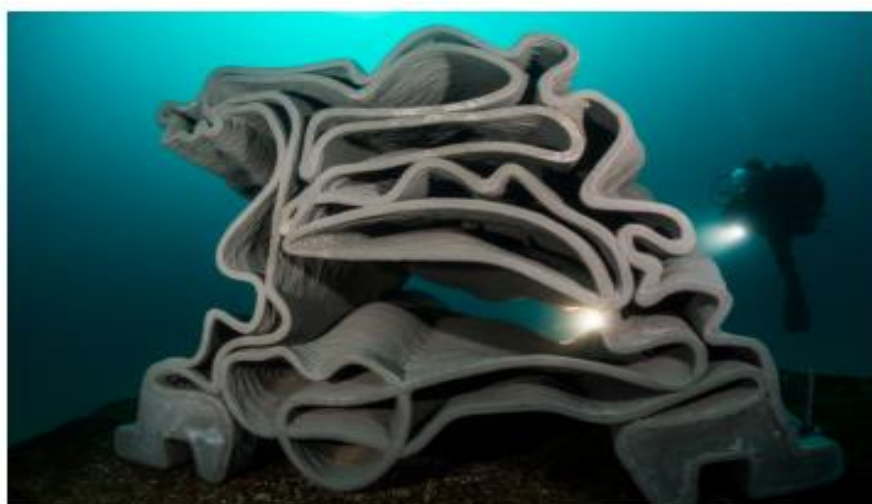
Figure 3.11 : Exemple de structures complexes réalisées par impression 3D béton : récifs artificiels immergés. Les nombreuses alvéoles dessinées par le béton favorisent l'implantation de la faune sous-marine [17].
