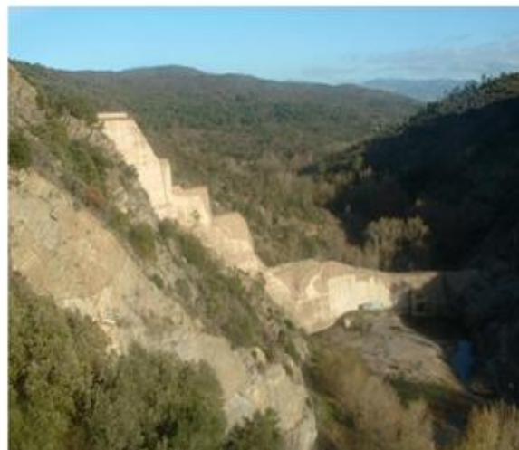
Rupture du barrage de Malpasset (France)
