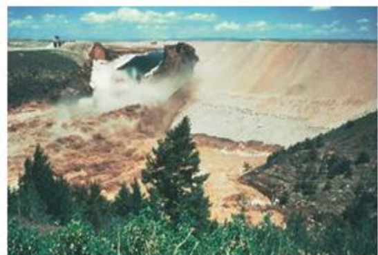
Rupture du barrage de Teton (USA)
