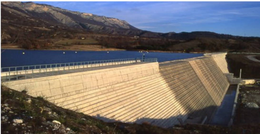
Figure I-4 : Barrage du Riou-BCR
