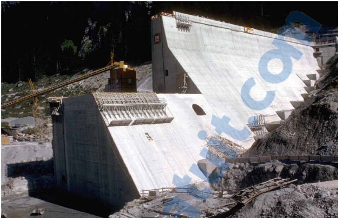
Figure I-1 : Profil type d'un barrage poids
