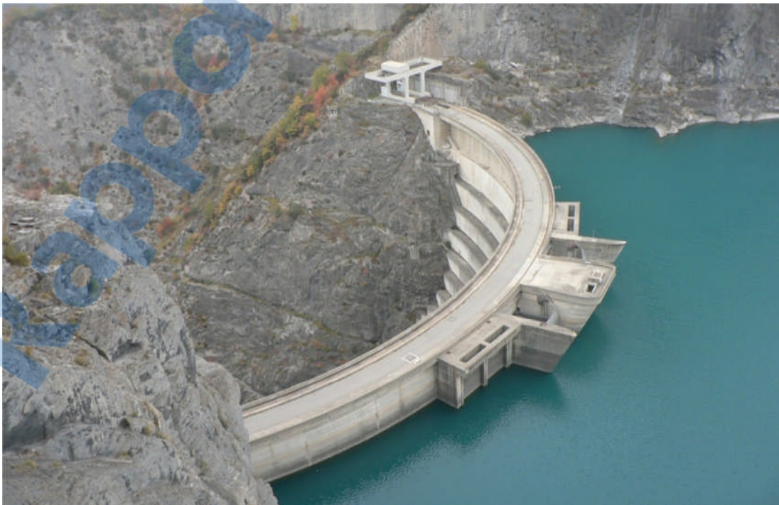
Figure I-2 : Le barrage de Monteynard (Isère, France)- voûte
