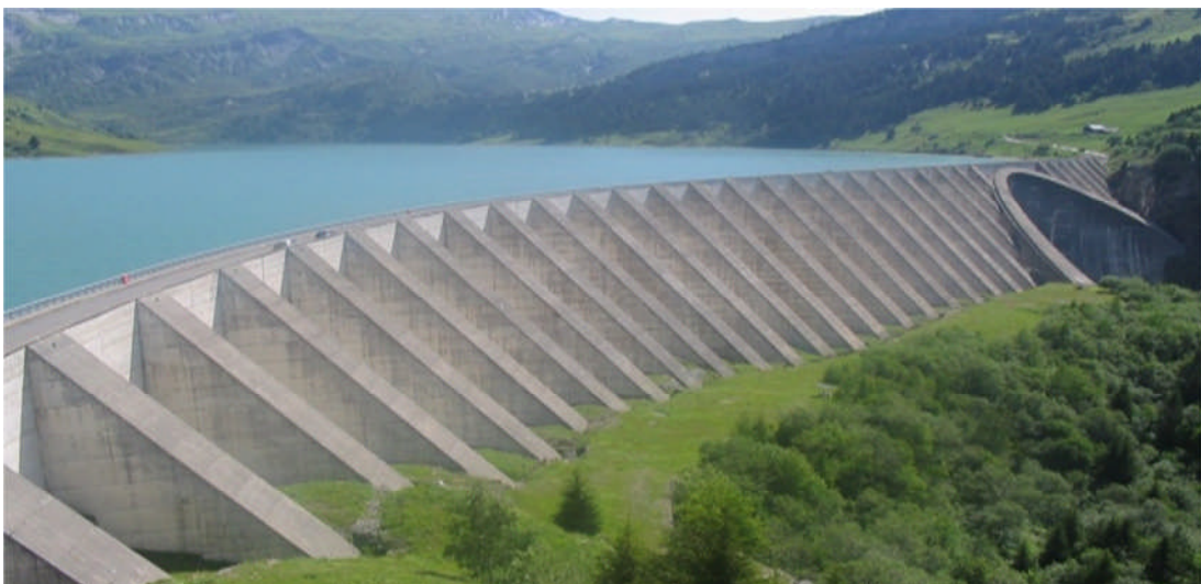
Figure I-3 : Barrage de d'Albertville, Rhône-Alpes, France (1955-1962)-contrefort
