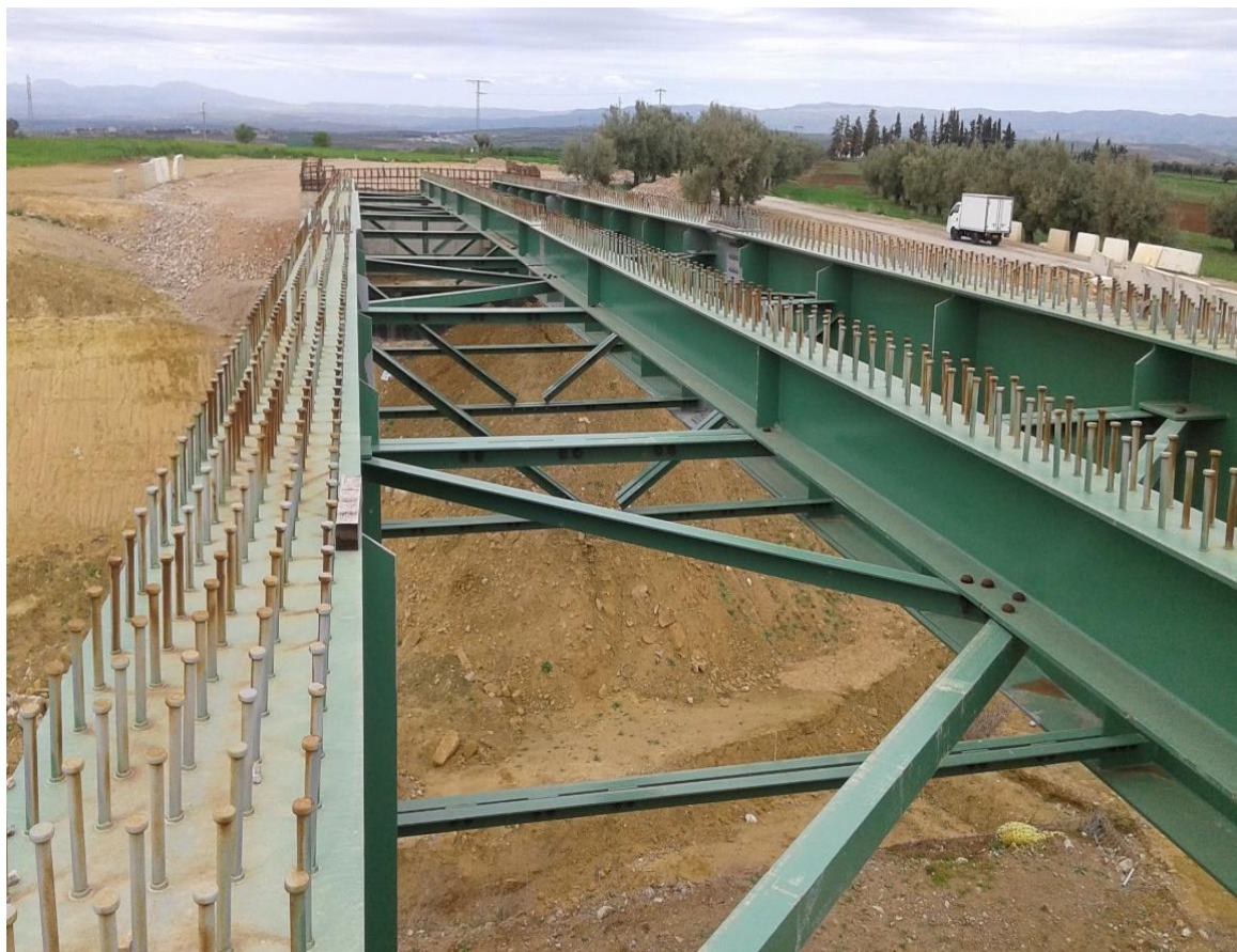
Figure 1-15 : Connecteurs de type goujons (5)
