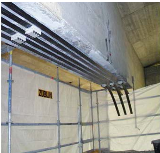
Figure I.10 : Consolidation de poutre et dalle par fibre de carbone [3]
