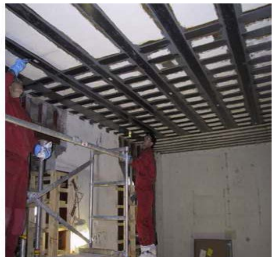
Figure I.10 : Consolidation de poutre et dalle par fibre de carbone [3]
