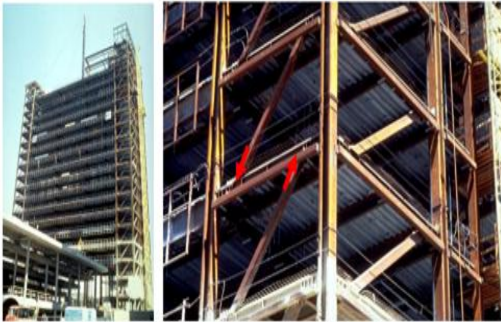
Figure I.13 : Contreventement excentré [3].
