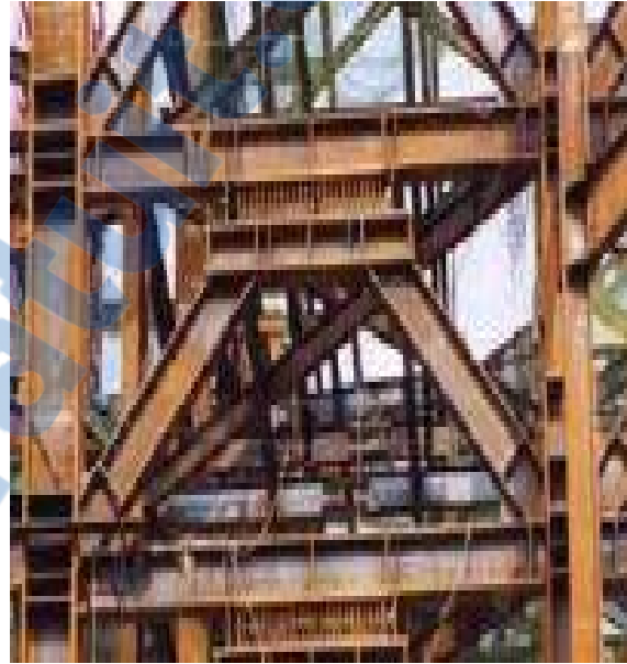
Figure II.3 : Amortisseur TADAS [8].
