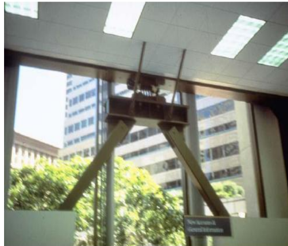
Figure II.2 : Amortisseur ADAS [9] [10].
