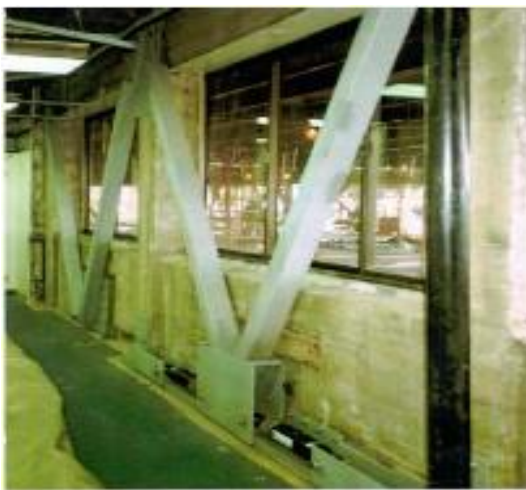
Figure I.10 : Contreventement en V [3].
