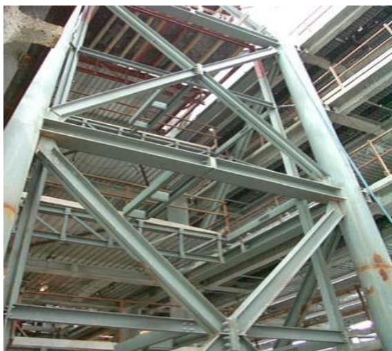
Figure I.7 : Contreventement en diagonales [7].
