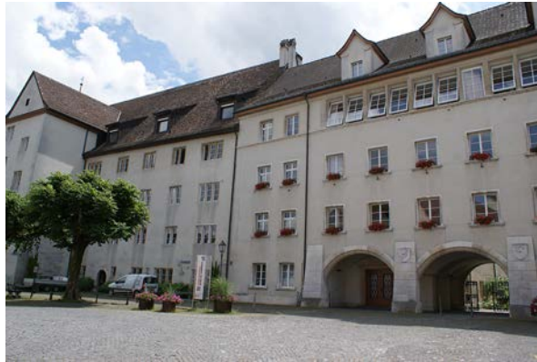
Figure 12 : façade du Lycée cantonal.
