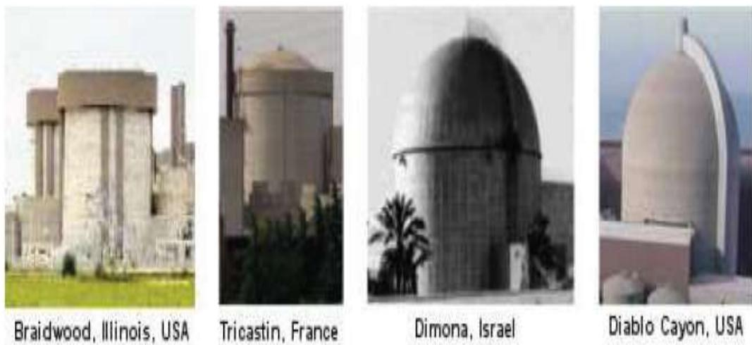
*Figure 3.3 : Différentes géométries d'enceintes de confinement*
