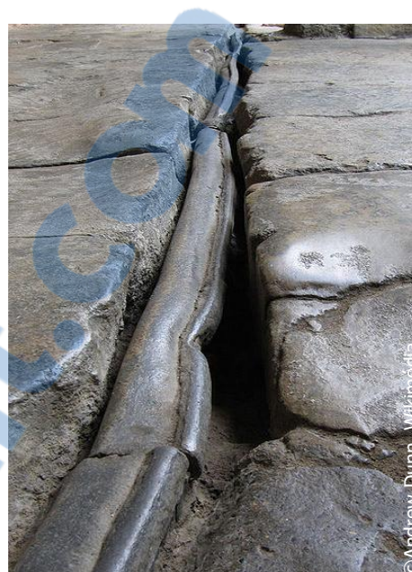
Photo 1 : Tuyaux en plomb de termes romains de Bath, Angleterre
