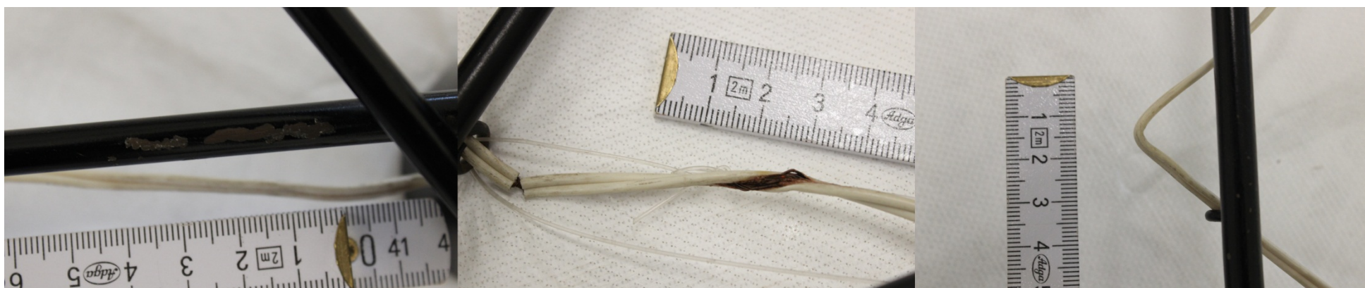
FIGURE 24, 25 & 26 De gauche à droite : Perte de matière au niveau du revêtement de la structure métallique (M1), rupture et fonte de la gaine du câble électrique (P3) et durcissement visible de la gaine en PVC (P3). ©HECR-Arc.
