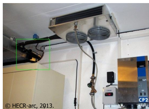
Photo. 2 : Trou dans le mur entre la zone Archive et la zone Entrée.
