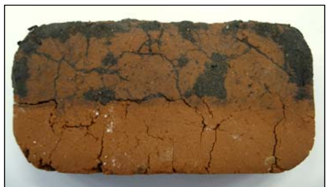
Fig. 36 : Présence d'un voile de terre assez important après nettoyage avec l'AB®57
