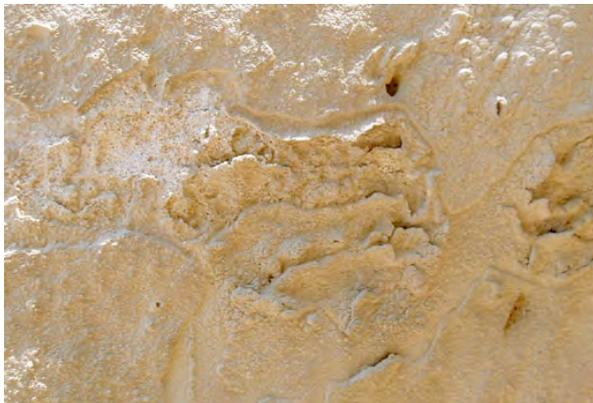
Photo 64: Zone très poussiéreuse et peu stable. La couche de poussière s'exfolie sur plusieurs niveaux.
