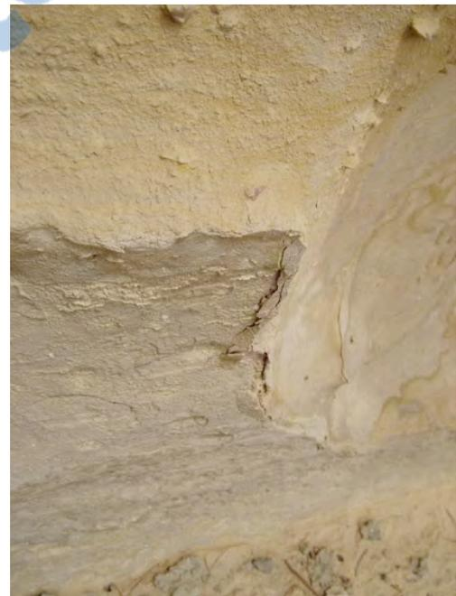
Photo 31: A la limite d'une zone prélevée, on voit la surface originelle qui se fendille et tombe.
