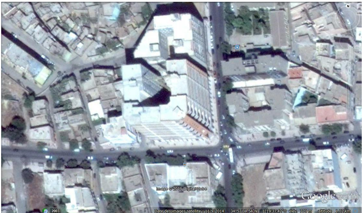
Figure.1.1: Vue panoramique de l'immeuble.
