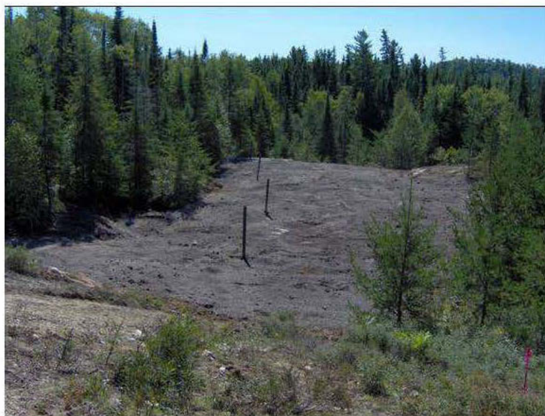
Figure 6.15 État du site après la mise en place de la filière de traitement du DMA
