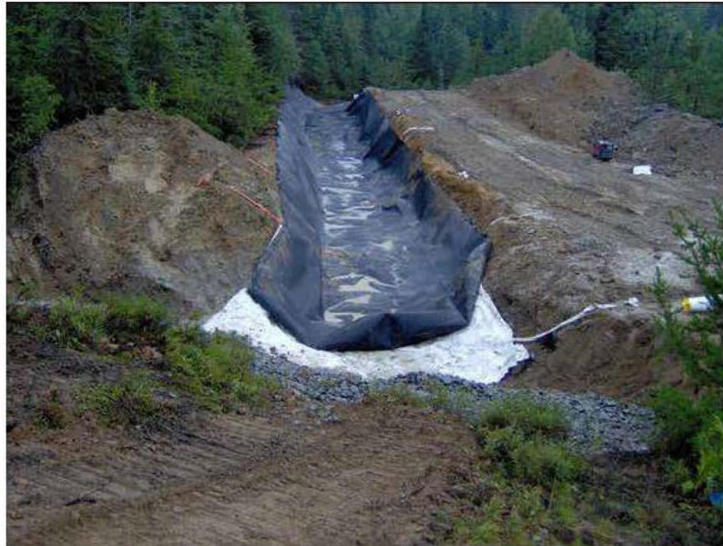
Figure 6.7 Mise en place de la géomembrane
