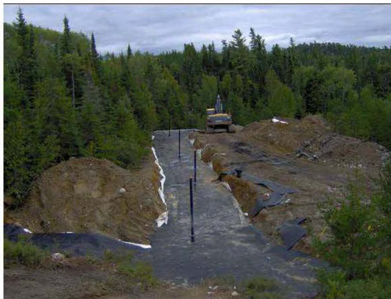
Figure 6.10 Mise en place de la géomembrane supérieure sur le système de traitement et le drain de collecte du DMA
