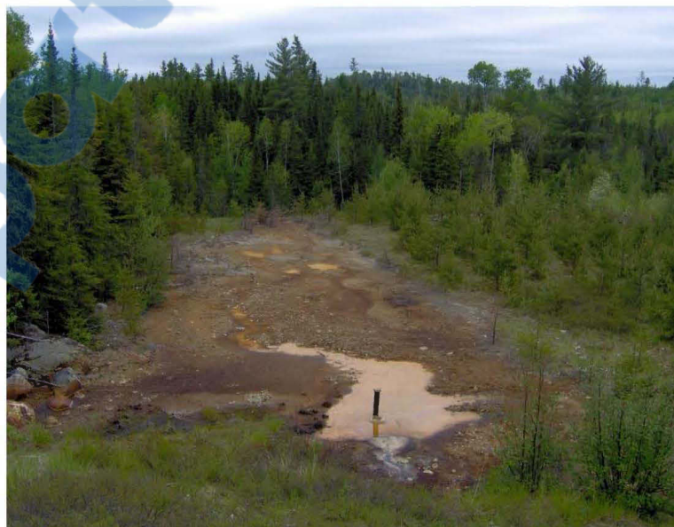
Figure 6.3 Accumulation de DMA sur le dessus du drain DOL-3 en 2007
