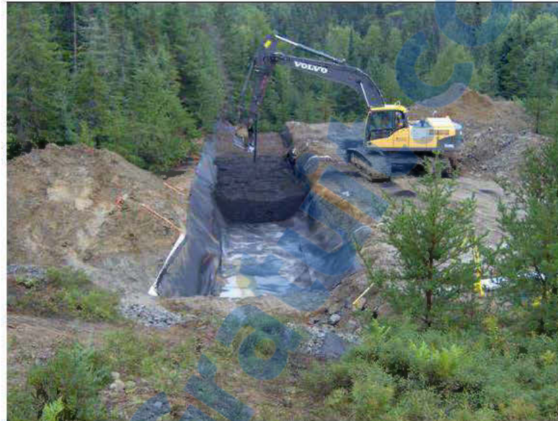
Figure 6.12 Dépôt des matériaux dans la filière de traitement
