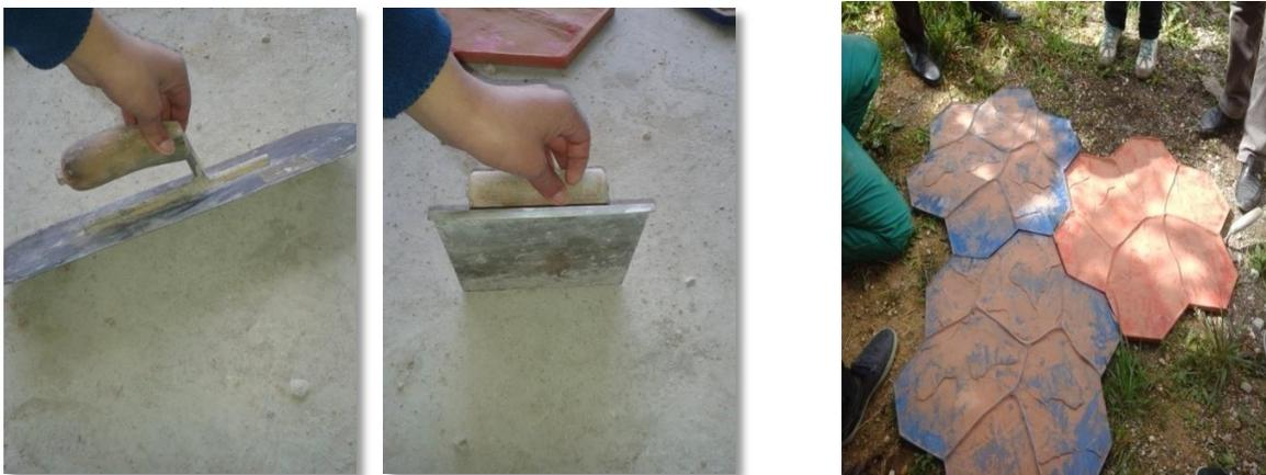
**Figure 1. 3. Matériel utilisé pour la réalisation d'Artevia Empreinte chez LAFARGE (photos prises par les auteurs)**
