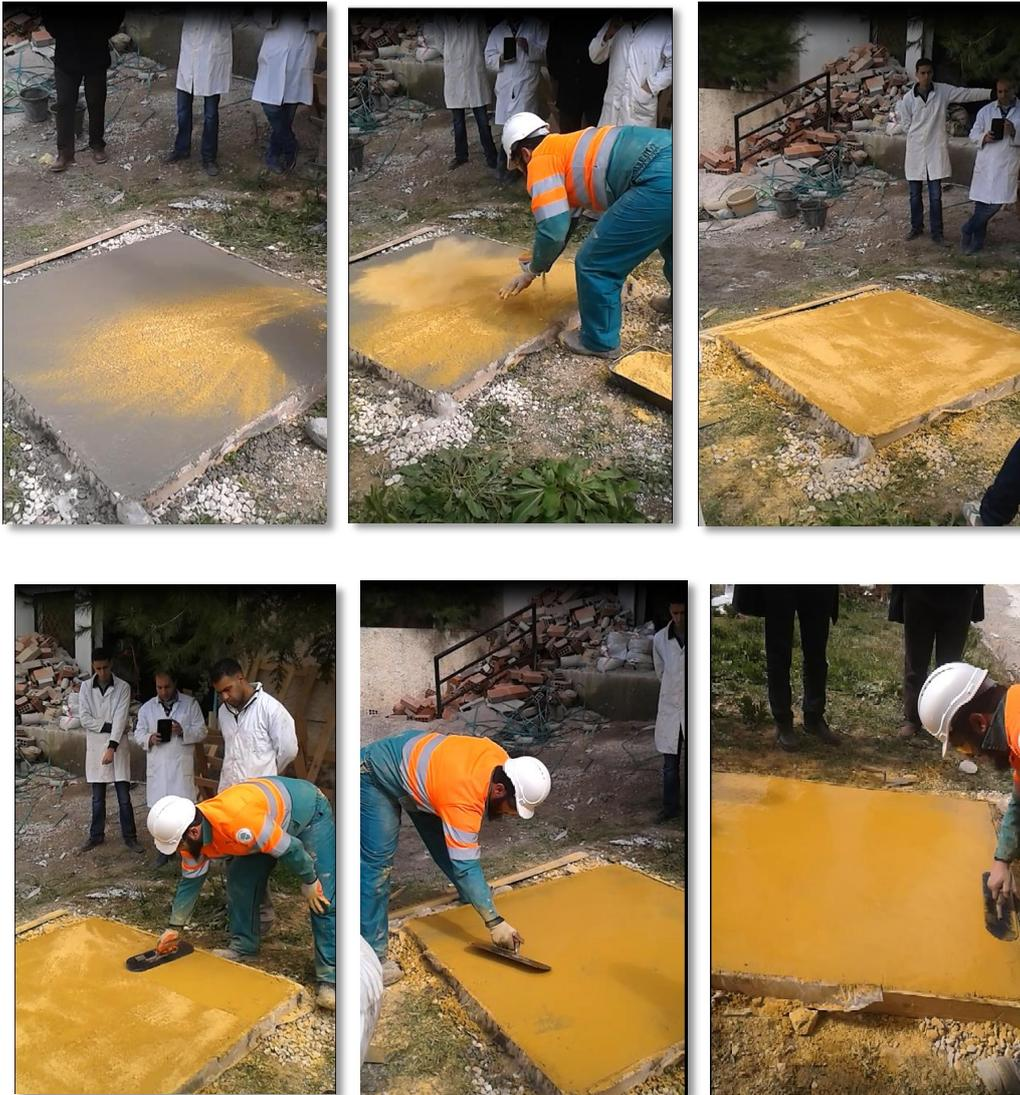
**Figure 1. 5.** Epandage et lissage du colorant en surface (photos prises par les auteurs)
