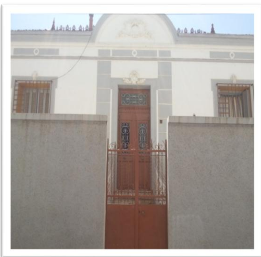
Photo 19.20 : Maisons en bon état
