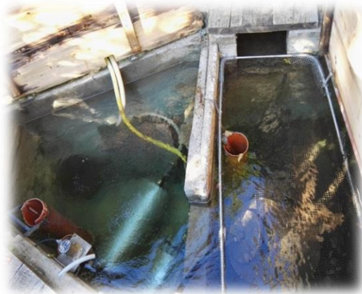
Figure 9: Système de dégrillage
