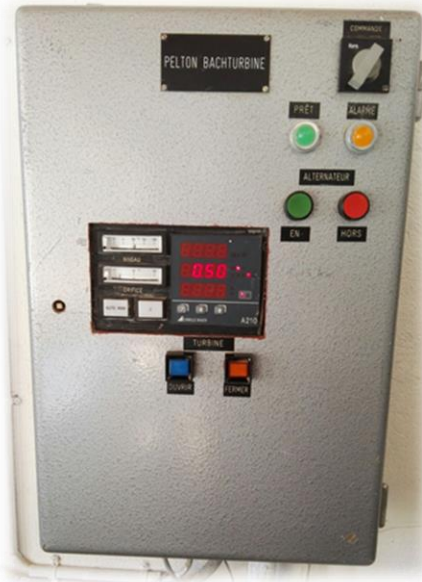
Figure 12: Tableau de commande turbo-groupe 4
