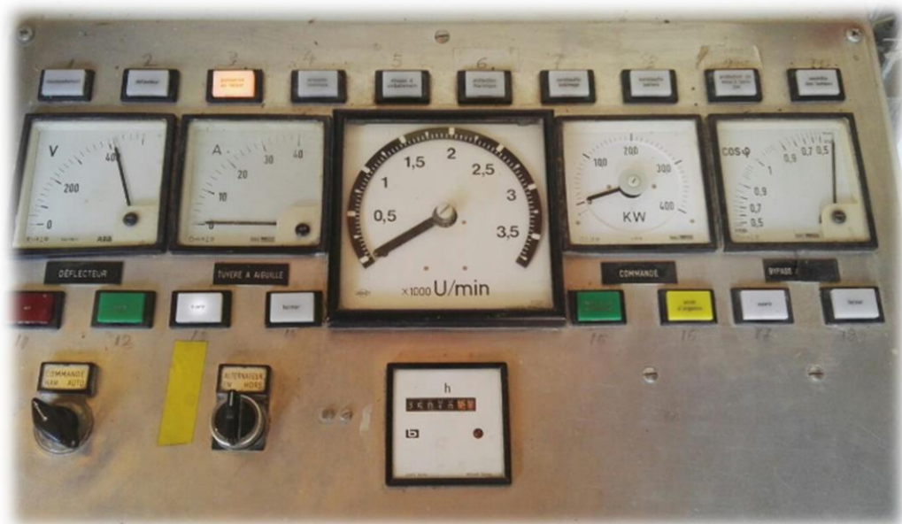
Figure 14: Tableau de commande turbo-groupe 1
