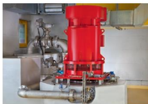
Turbine du Profray à 2 injecteurs, sur les eaux usées brutes (Q = 0.100 m 3 /s, H n = 430 m, Dext = 648 mm, 1500 t/min, P m = 380 kW)
