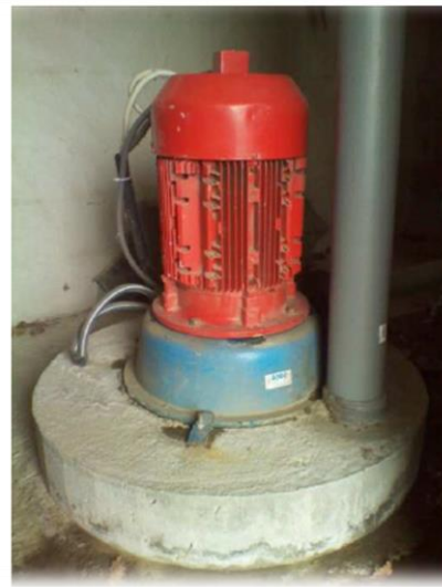
Figure 3: Turbo-groupe 1 : Source [9.1]: (Rapport de visite des aménagements liés au turbinage du Torrent de Beudon, Juin 2016)
