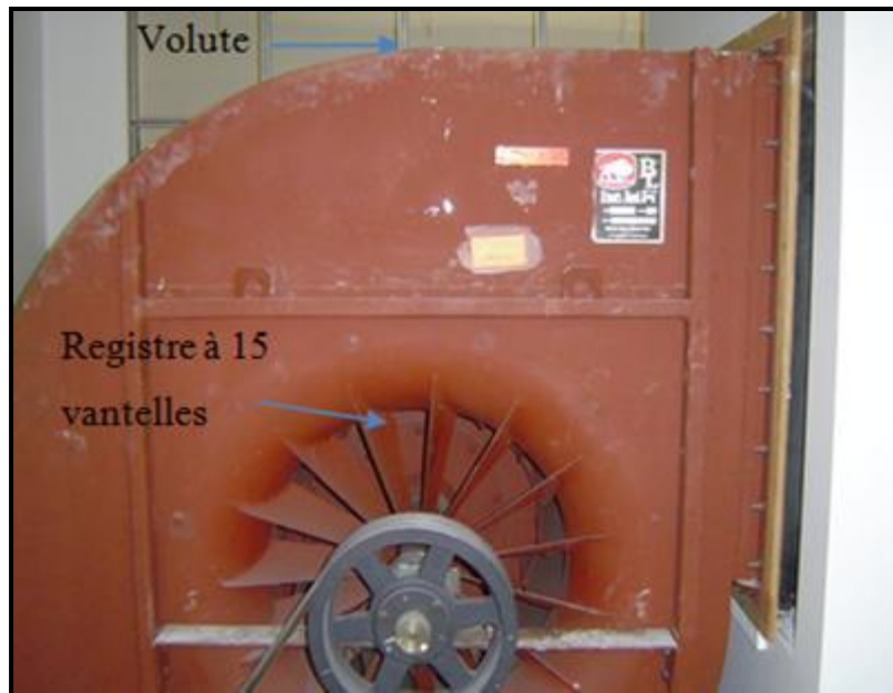
Figure-A-I-4 Ventilateur centrifuge à double turbine
