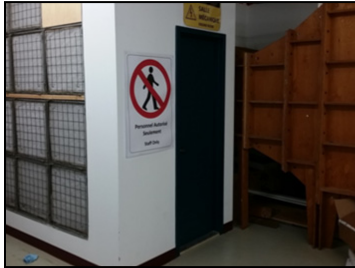
Figure-A-I-1 Extérieur de la salle mécanique
