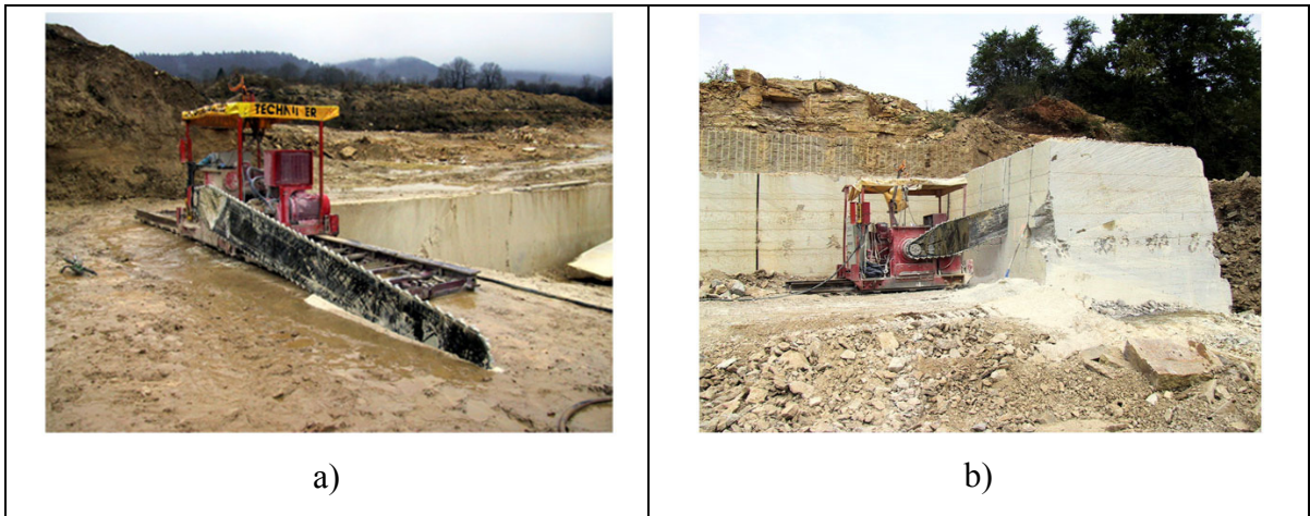
Figure 2.1 Scie à haveuse pour l'extraction des blocs calcaires Tirée de http://www.mochalgranit.com
