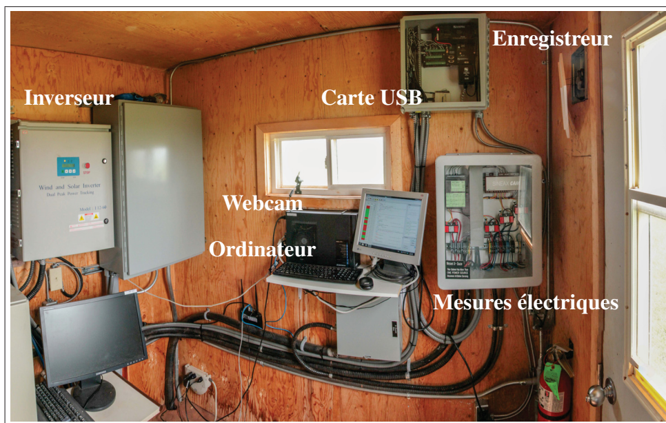
Figure 4.2 Dispositifs d'acquisition à l'intérieur de l'abri à la base de l'éolienne.
