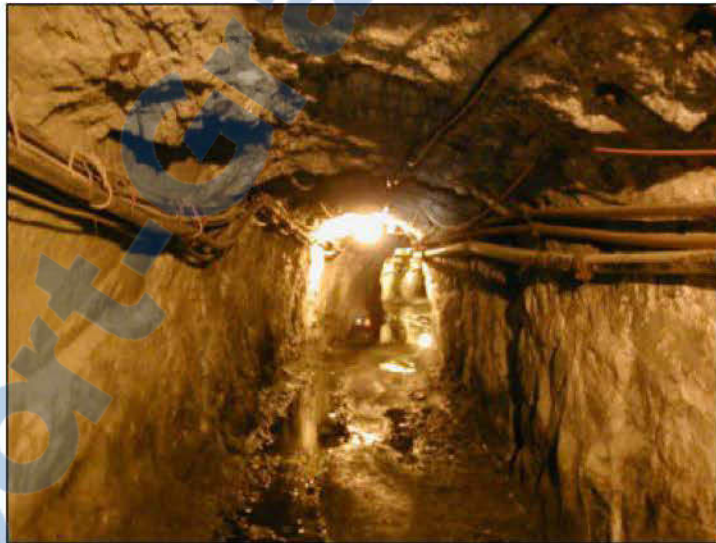
FIGURE 1. 1 — Galerie minière du niveau 70 m sous terre.
