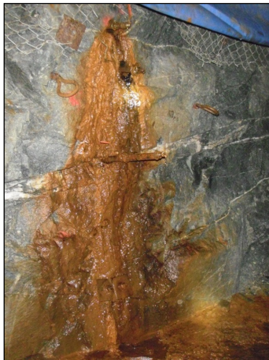
Figure 5.52 : Station d'échantillonnage (échantillon C-17) où il y a des oxydes et hydroxydes de fer visibles sur la paroi et sur le sol.
