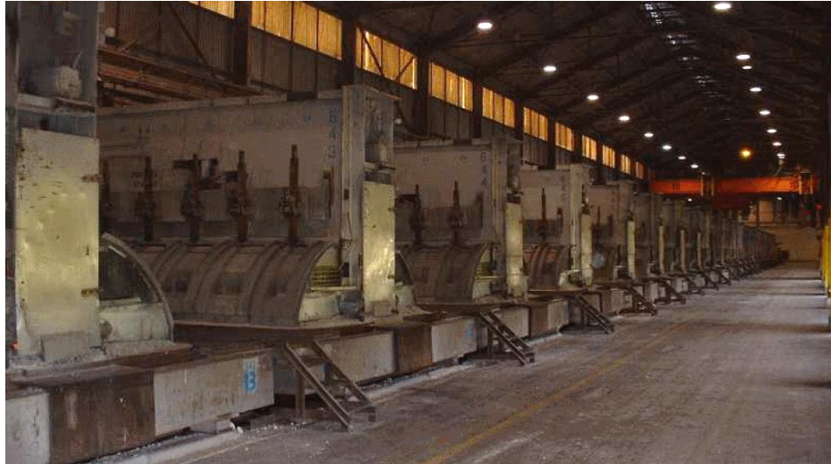
Figure 1-3: Salle de cuve utilisant la technologie P-155 [6]
