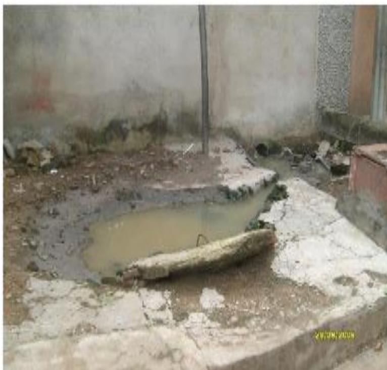
**Figure 11: Photo d'un puits perdu endommagé d'un habitat évolutif dans le quartier de Lazaret Nord.**
