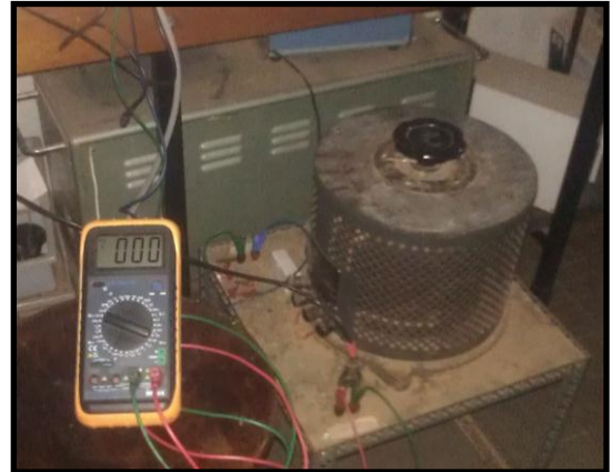
Figure 29 : Autotransformateur pour l'étalonnage de la tension
