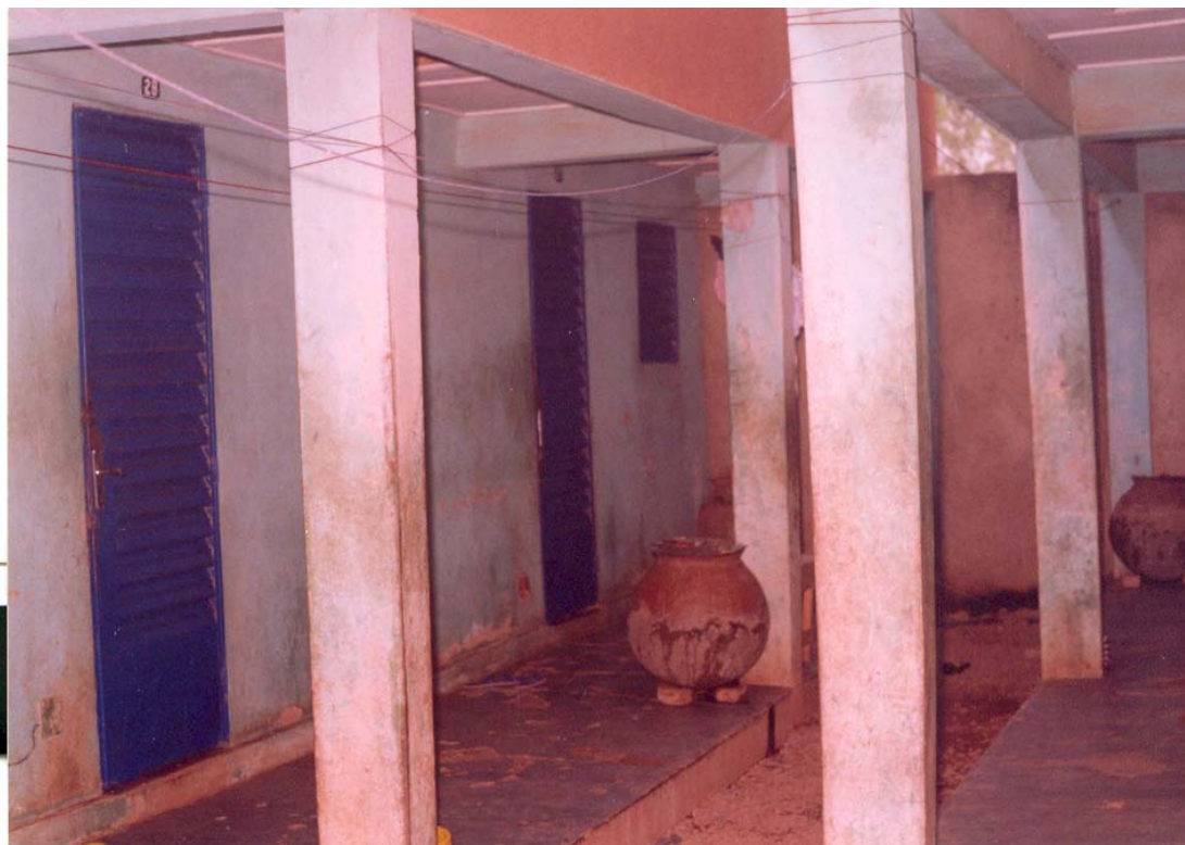
Extérieur des chambres de travailleuses du sexe
