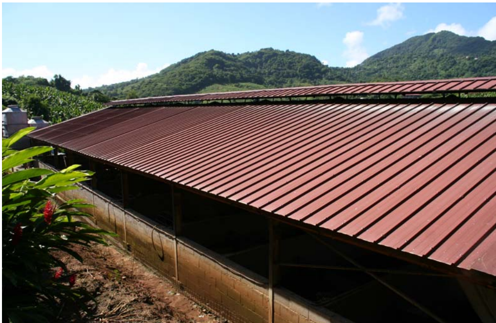
Figure 10. Vue extérieure d'un bâtiment professionnel d'élevage porcin (source personnelle)
