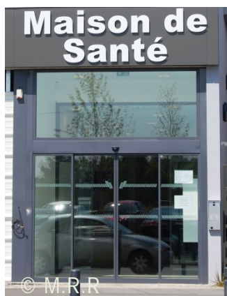
Document 10 : maison de santé des Hauts de Saint-Aubin
