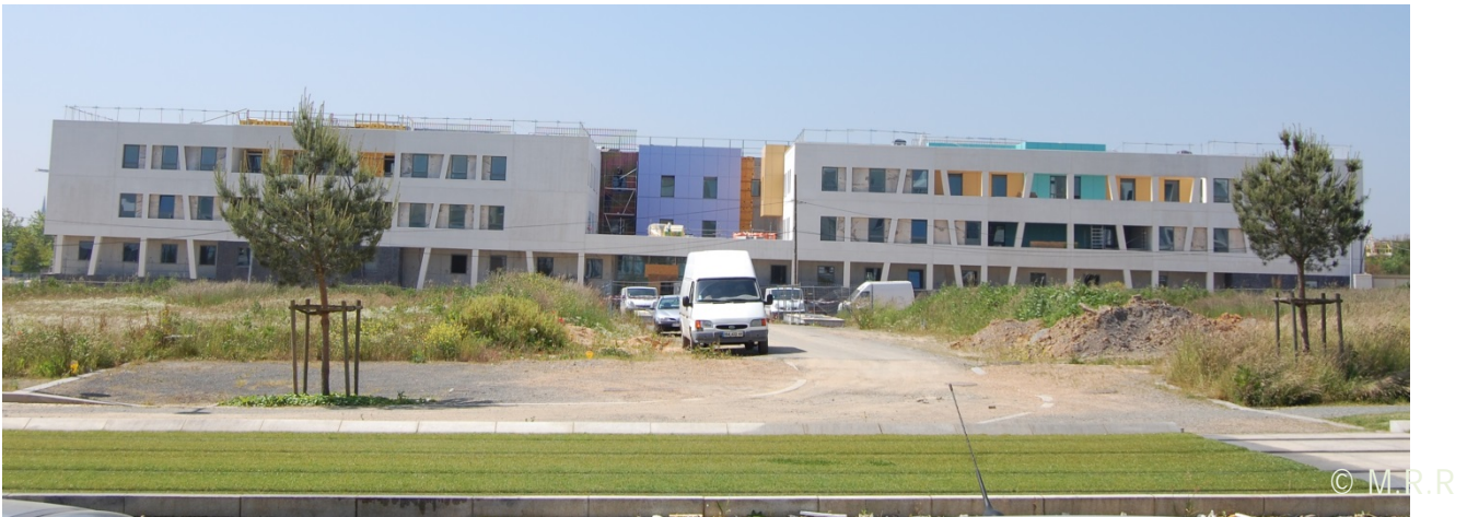
Document 9 : le bâtiment du CESAME en travaux, début juin 2013
