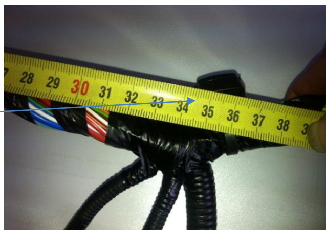
Figure 29: Emplacement de nœud non conforme
