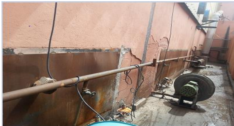
Figure 19 : Installation en dehors de la fonderie
