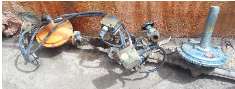
Figure 15 : Electrovanne avec détendeur
